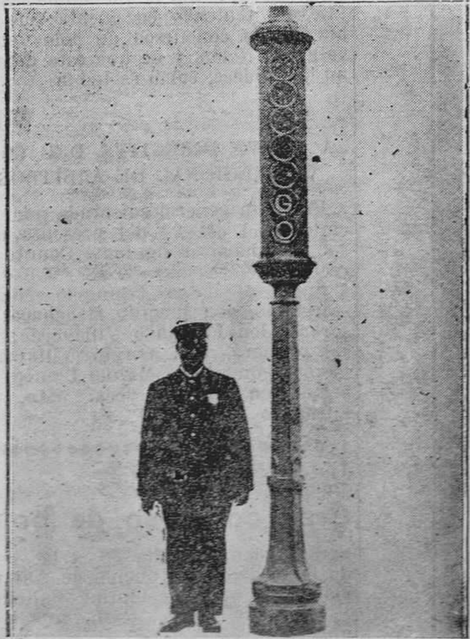
EL PROBLEMA DE LA CIRCULACION EN LAS CIUDADES.-Farola de trafico con reflector y control de mercaderías, que se usa con éxito en muchos países.
