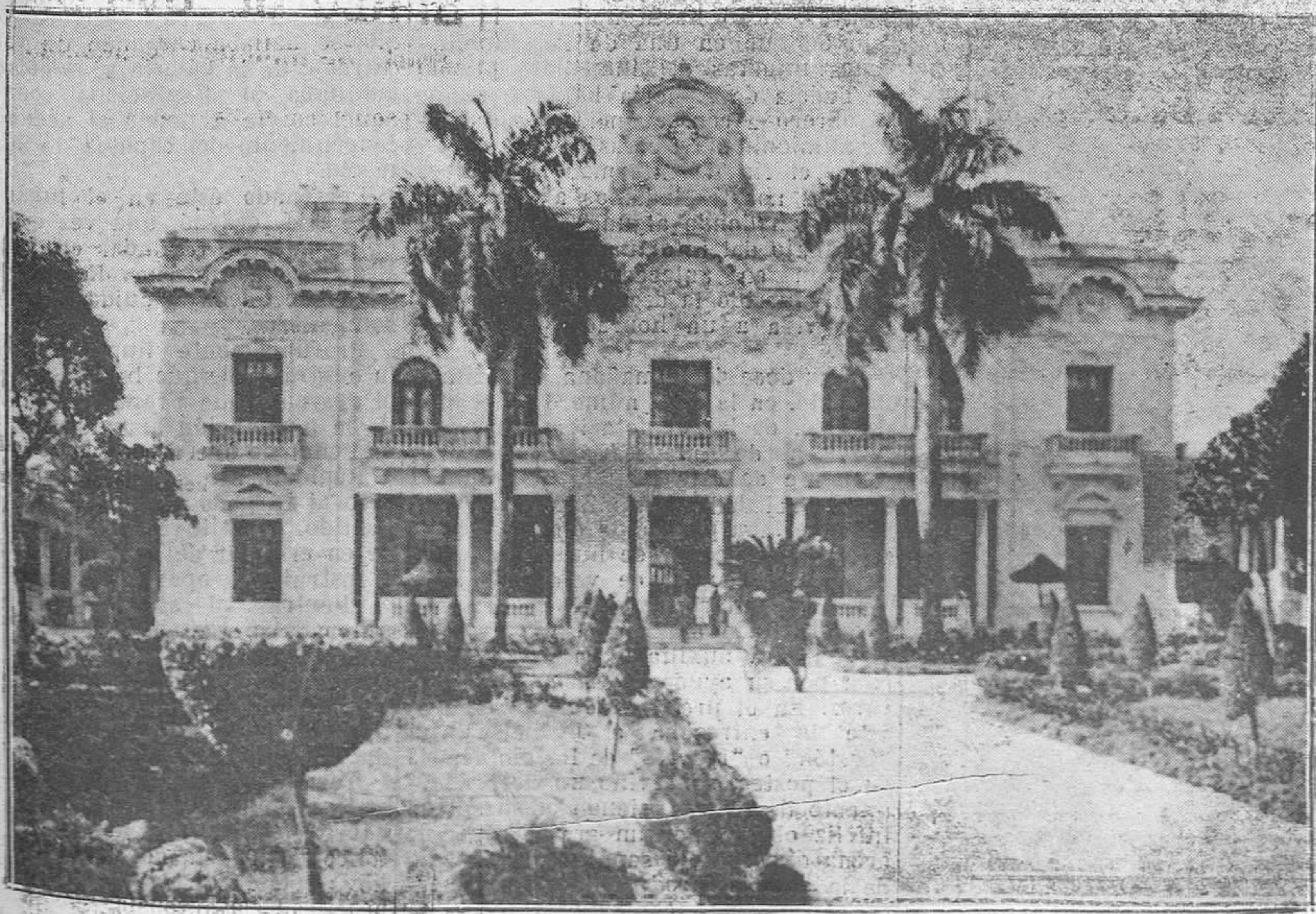
QUINTA "COVADONGA". Fachada principal del Palacio "Asturias" destinado a Administración.
