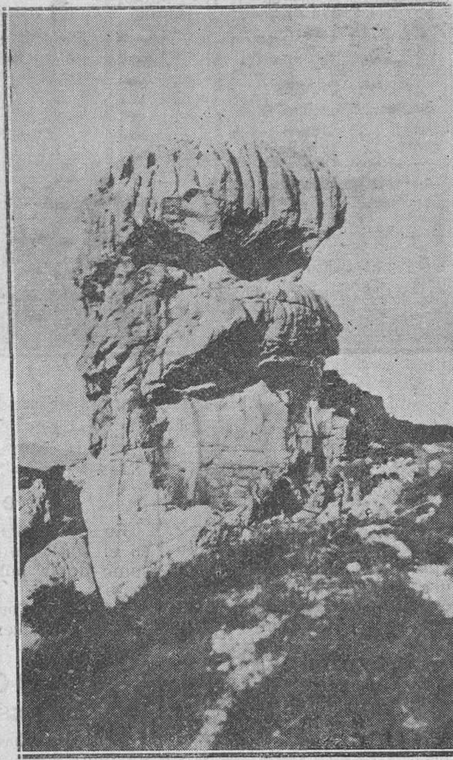
VIDIAGO (PUERTAS).-La majestuosa figura de Peña Tú, antes de las obras de defensa. (Foto Ramón Sordo)
