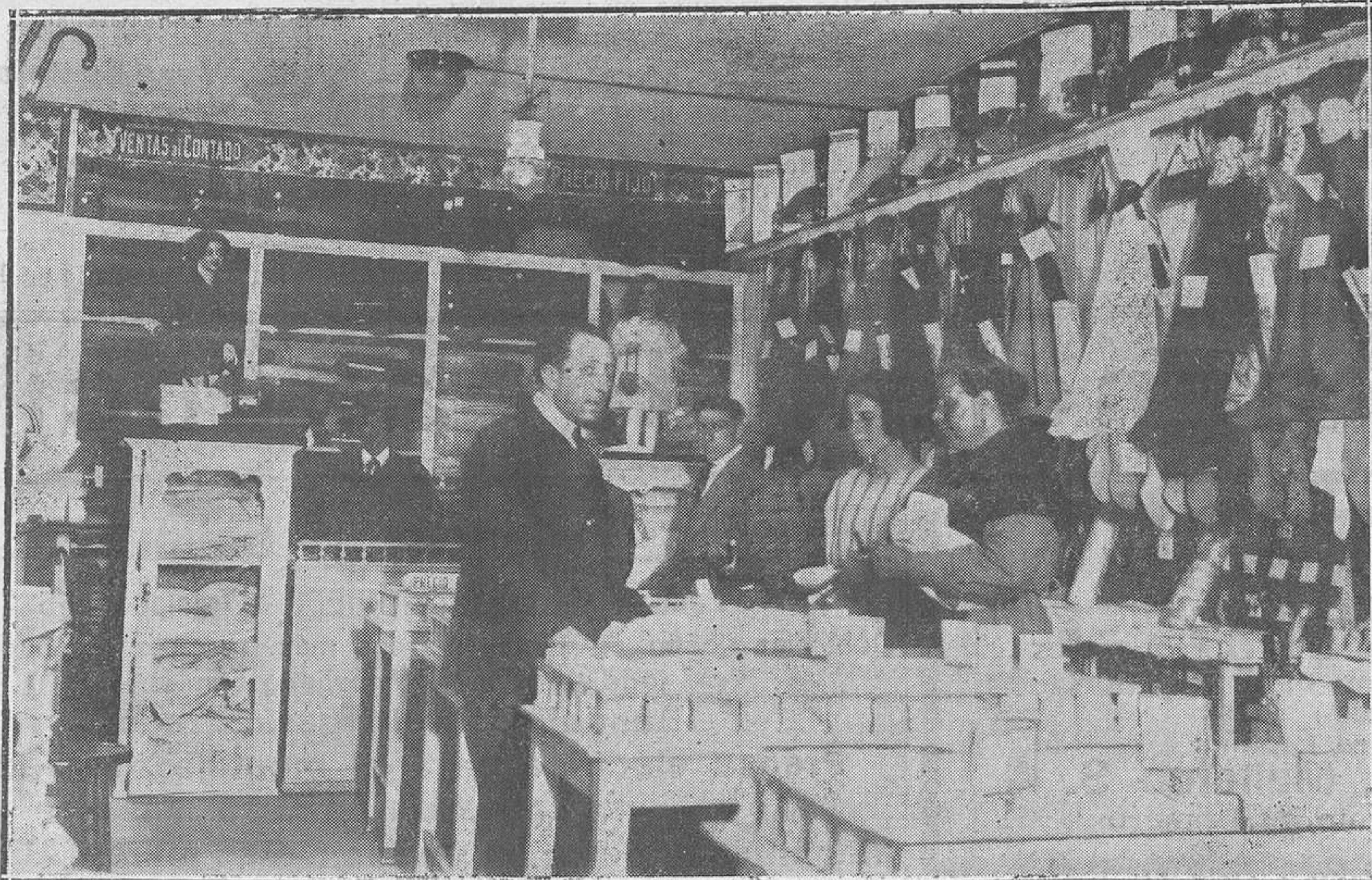
Nueva instalación de la CASA FROILAN, abierta al público hace unos días en la calle de Cimadevilla, número 7 (Foto Buelta)
