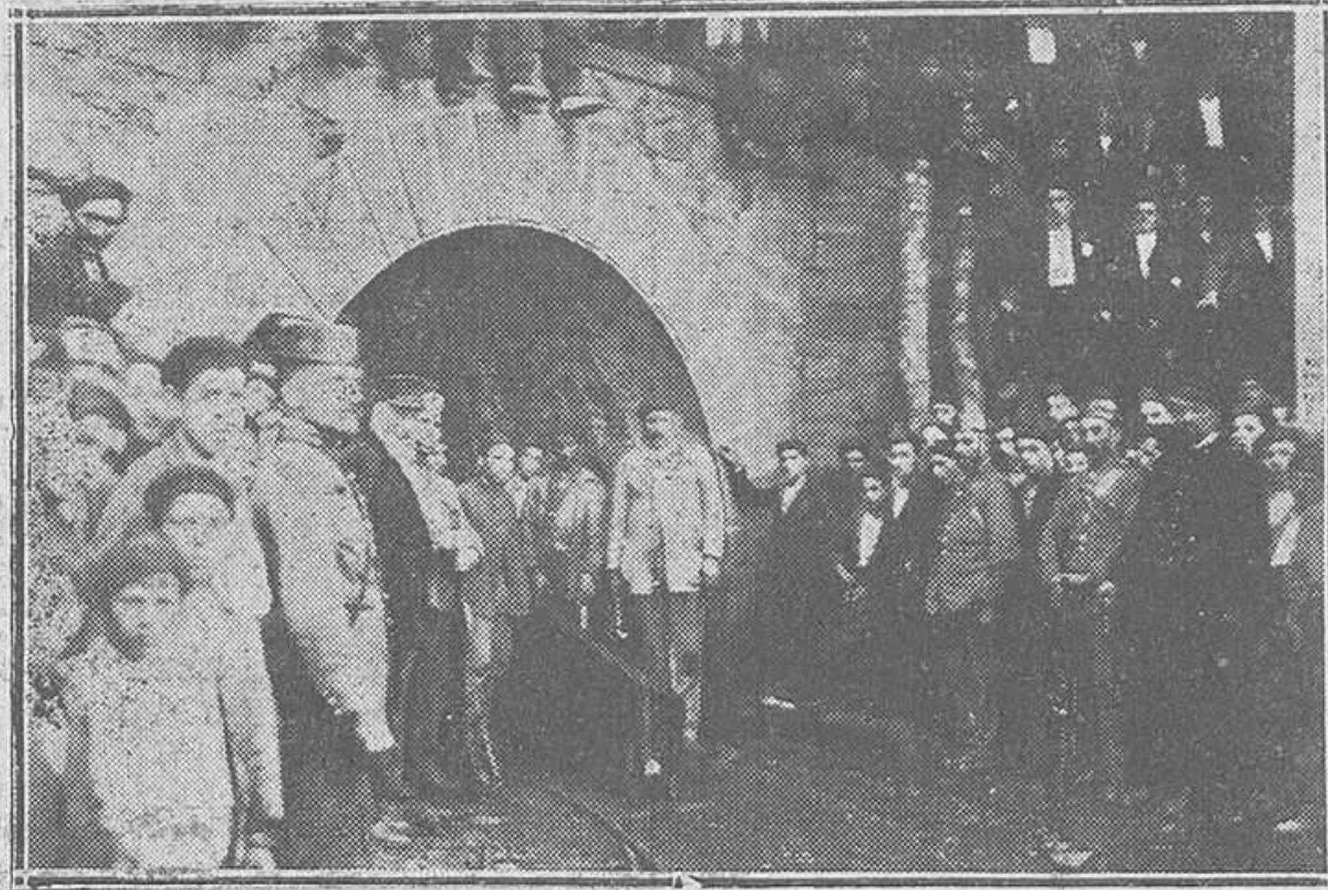
LA CATÁSTROFE DE CABORANA.-Bocanina del séptimo piso donde ocurrió la explosión. (Foto Marañón)
