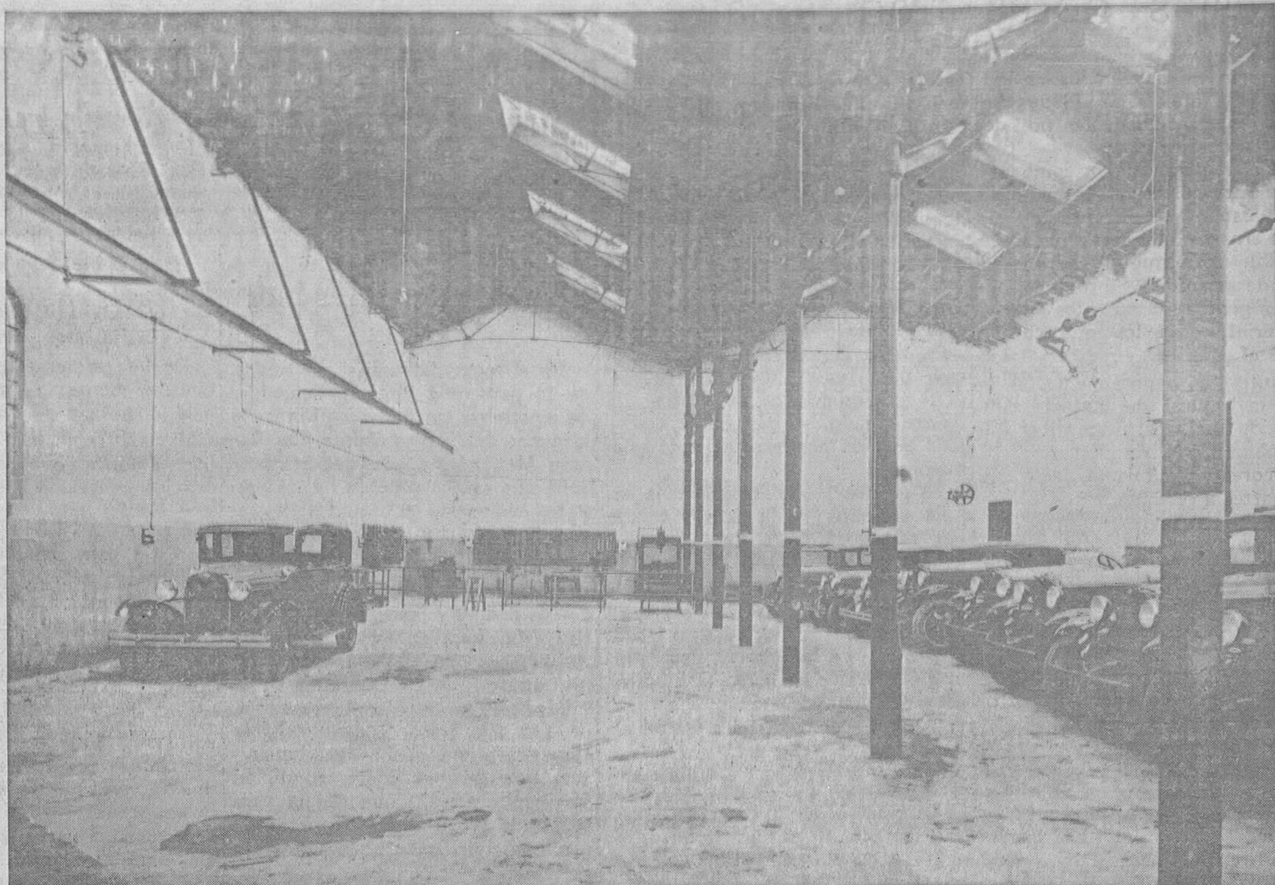
VISTA DE TALLERES Y DEPOSITO "FORD"
