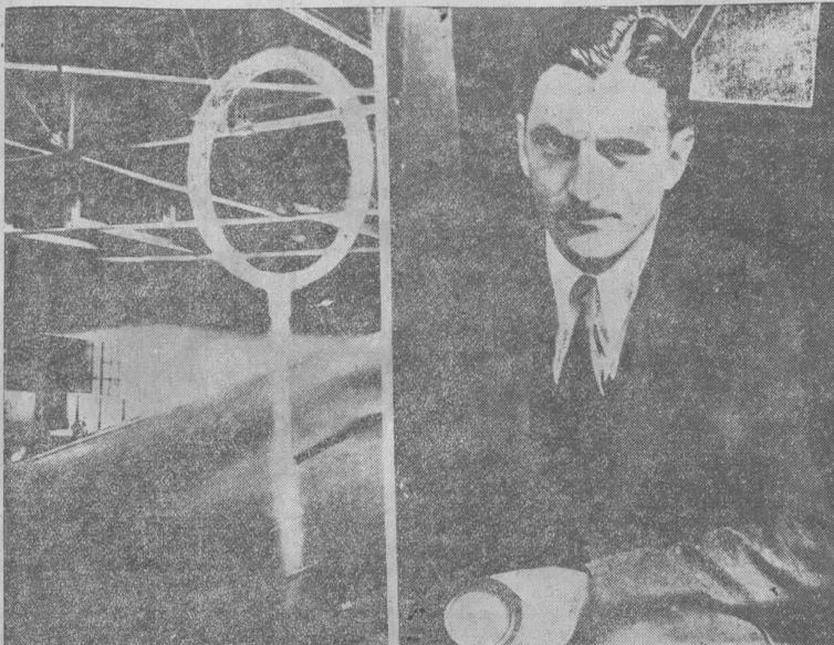
En los Estados Unidos se ha inventado un nuevo aparato para guiar a los aviones por medio de la T. S. H. A la izquierda, la antena receptora que va colocada en el ala del aparato. A la derecha, el registro de dirección
