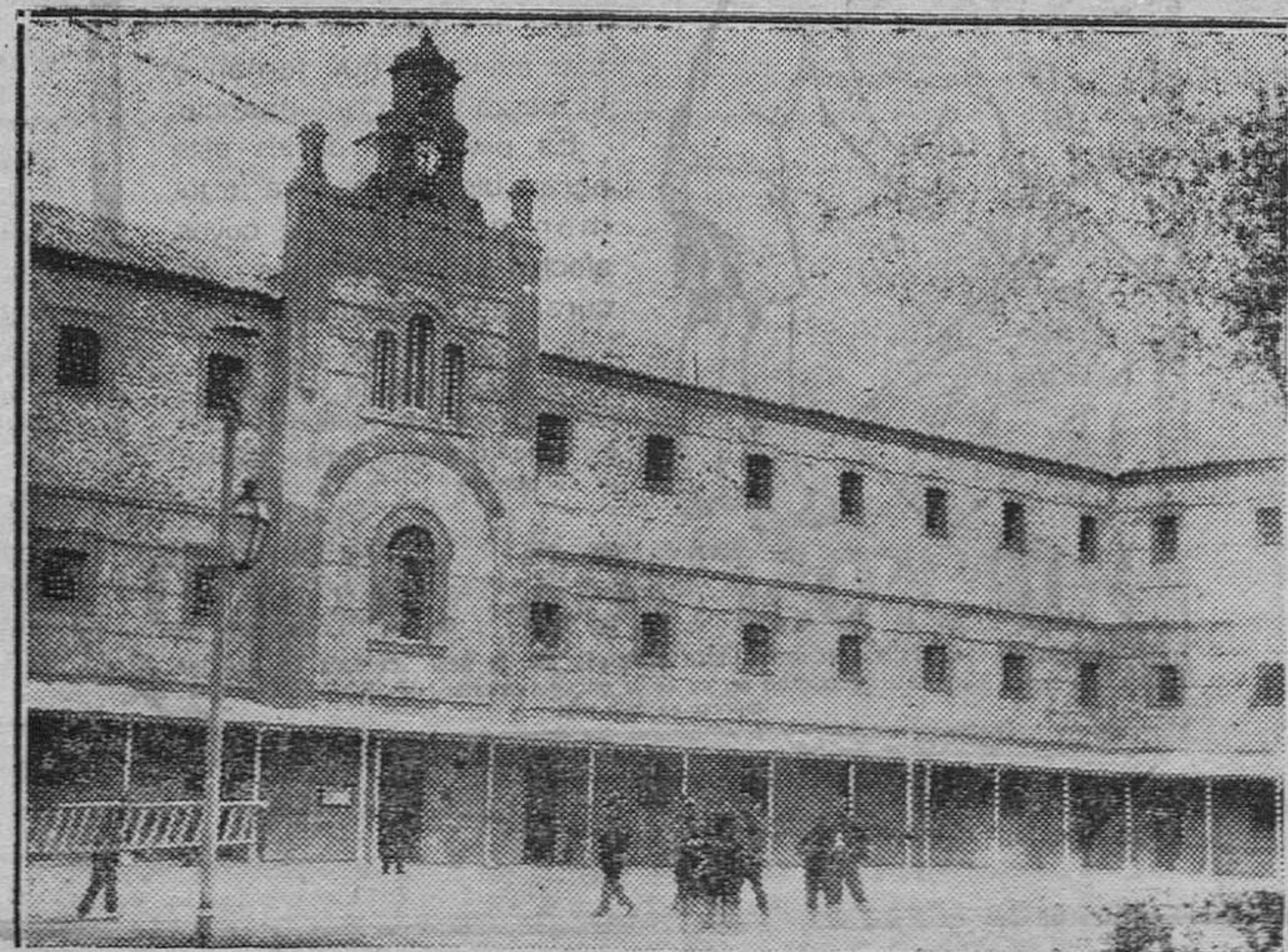
Vista de uno de los pabellones del Reformatorio penitenciario de Ocaña, que fueron destruidos por un incendio, siendo reconstruido el primer piso y construido de nueva planta el segundo.
