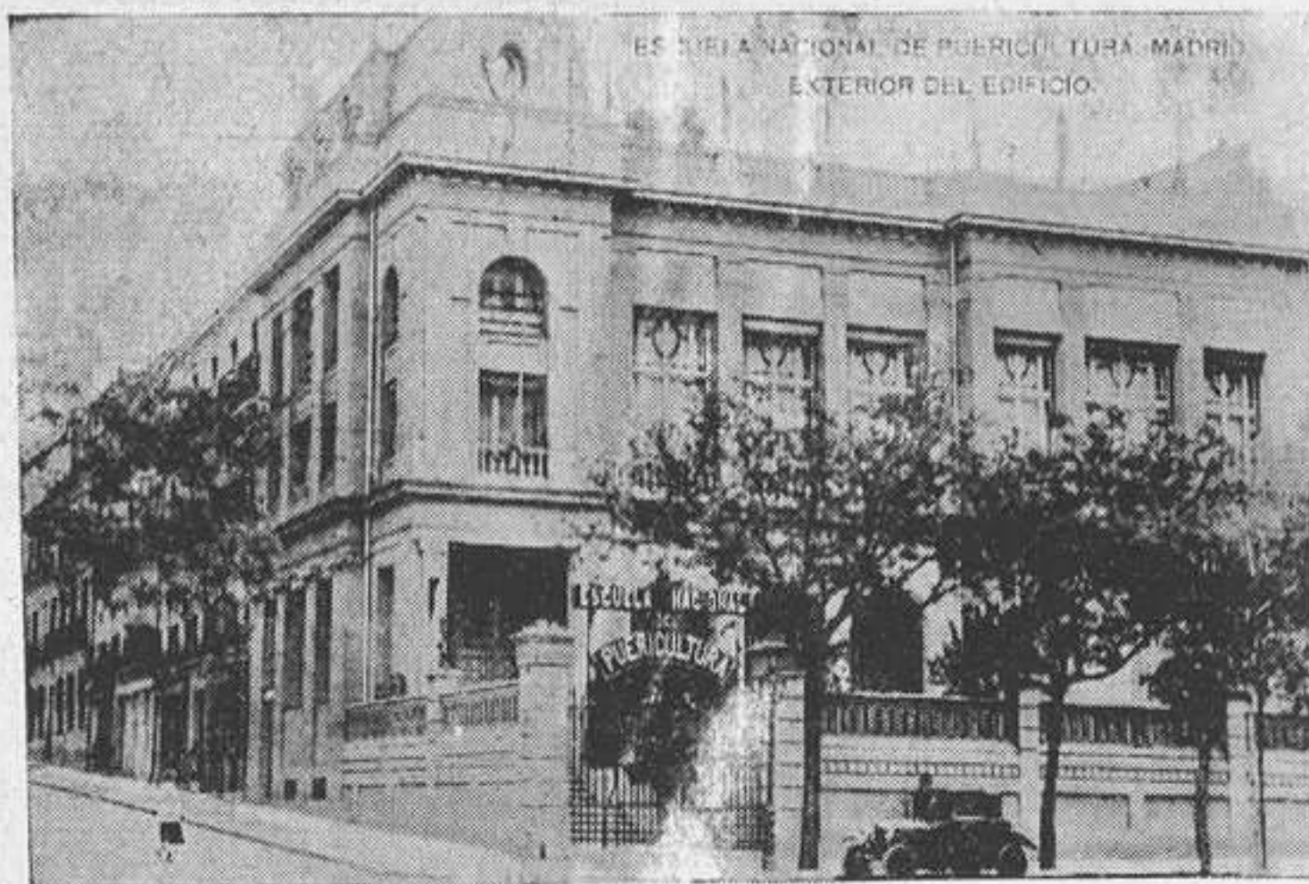
Vista general de la Escuela.
