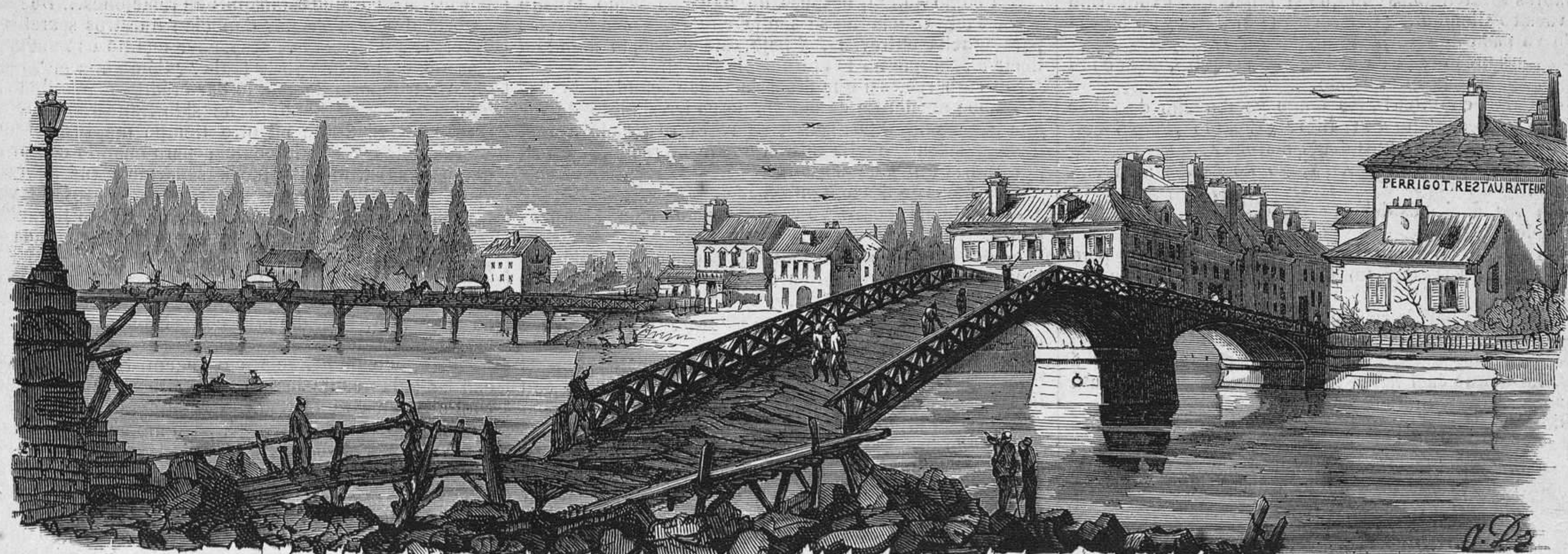
El puente de Lagny.
