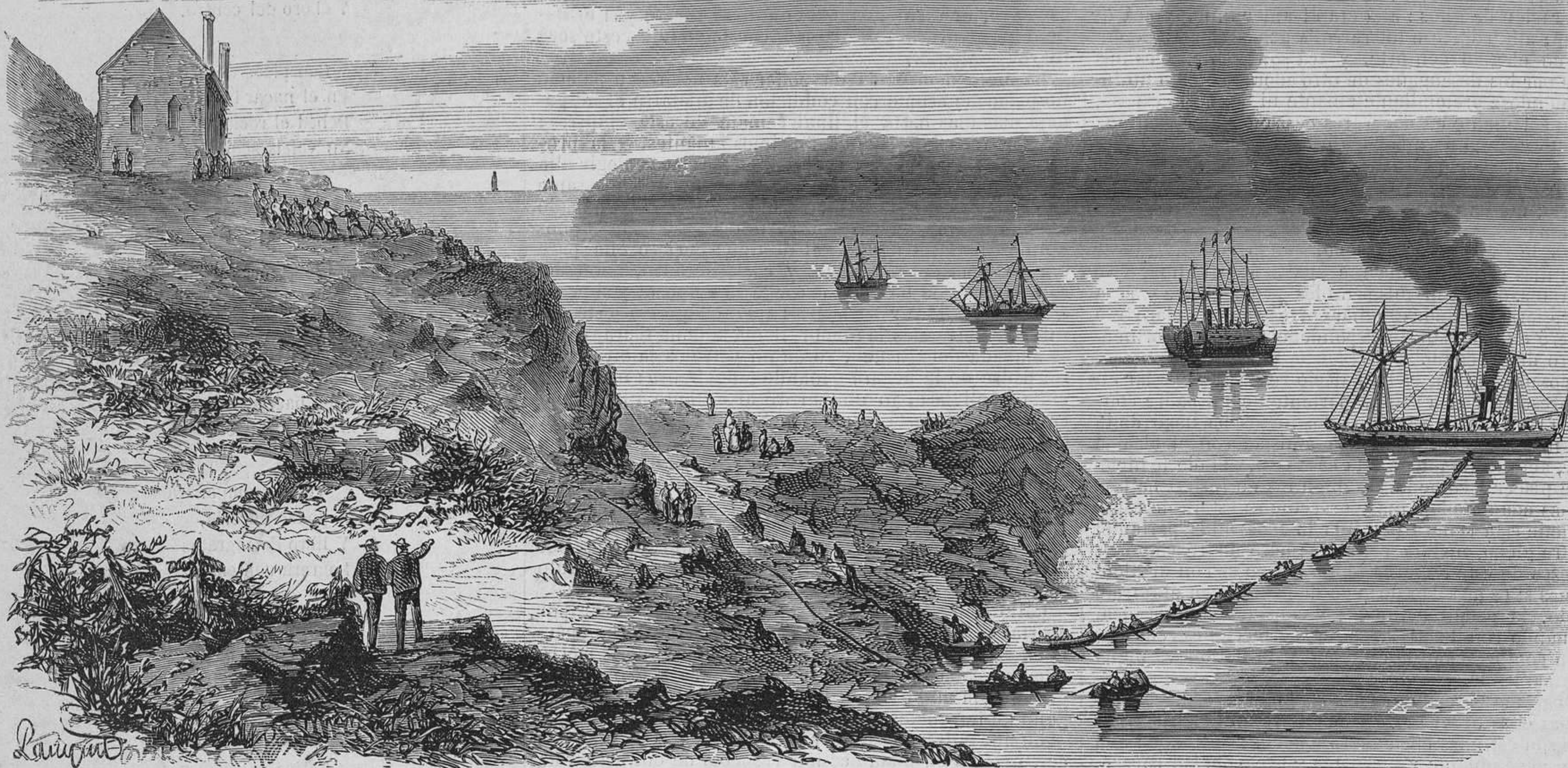
El cable trasatlántico francés. — Desembarque de la extremidad del cable destinado á unir la isla de Saint-Pierre al continente americano.
