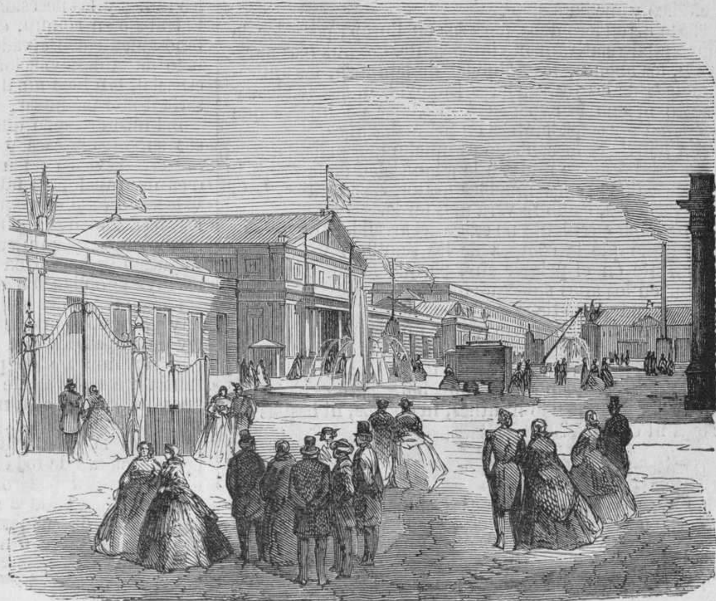
FACHADA PRINCIPAL DEL PATIO, VISTA POR EL LADO DE LA CIUDAD.
