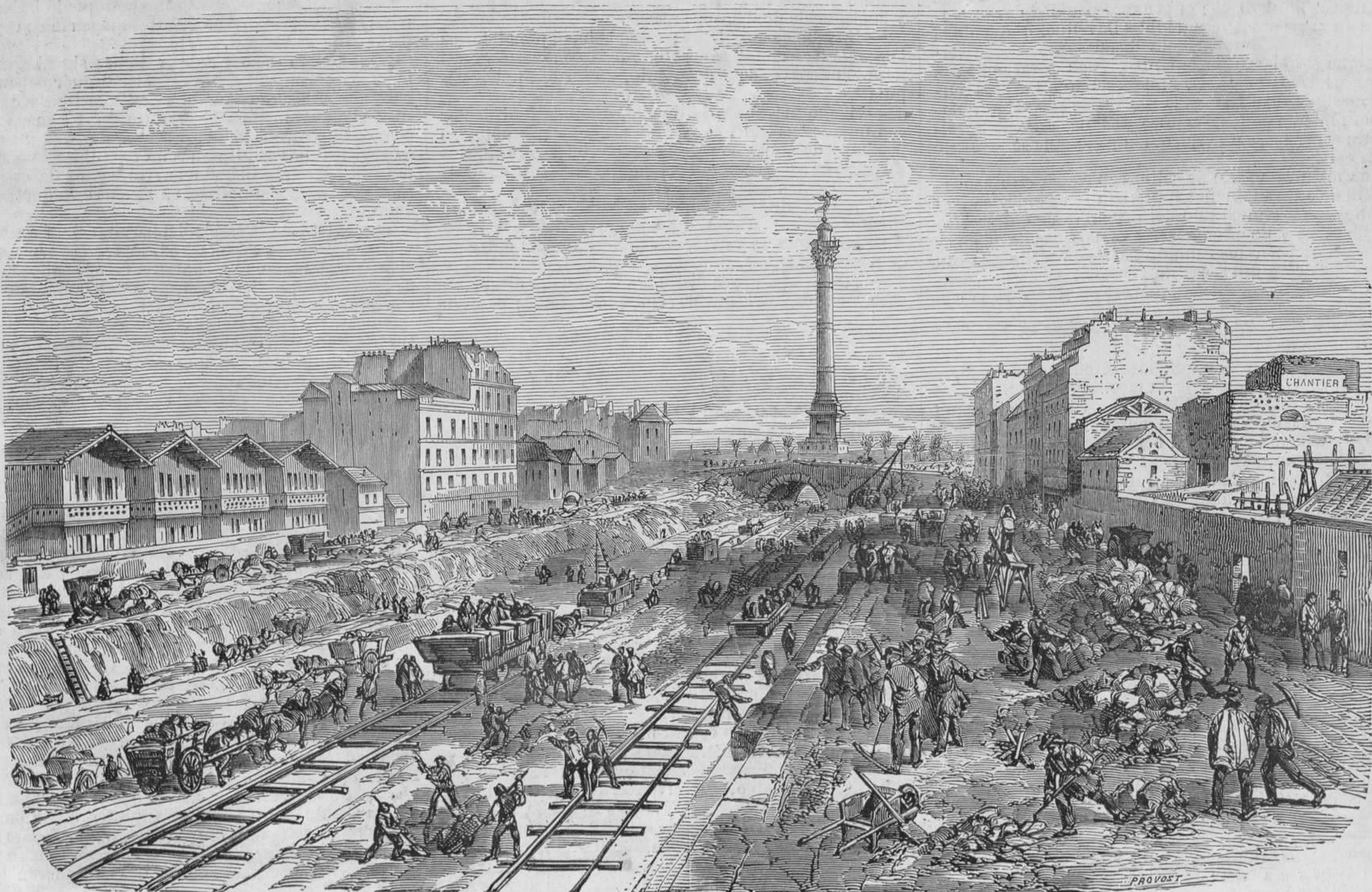
LAS OBRAS DEL CANAL SAN MARTIN EN PARIS.
