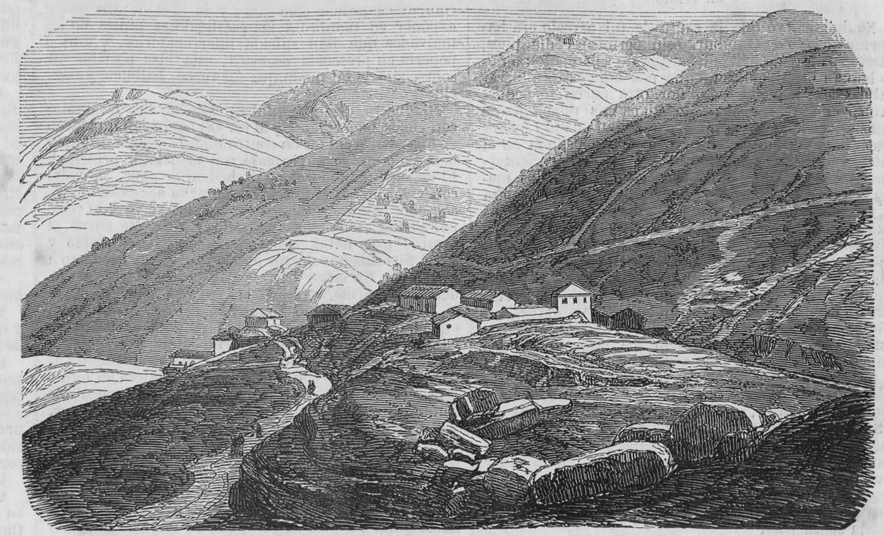
Aldea de Camaro, sobre la derecha de Balaklava.
