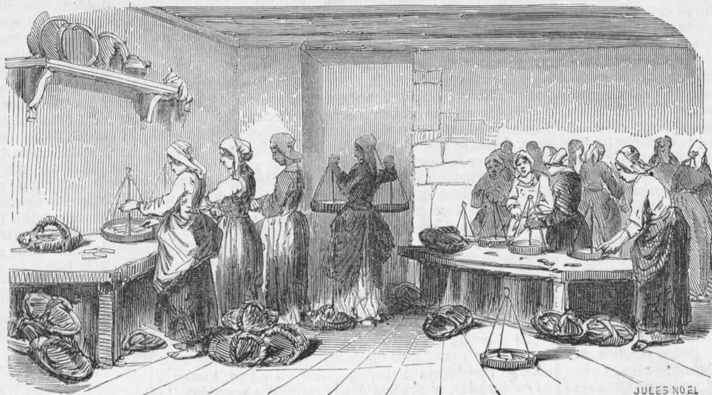
Colocacion de las sardinas sobre las cestas-parrillas.
