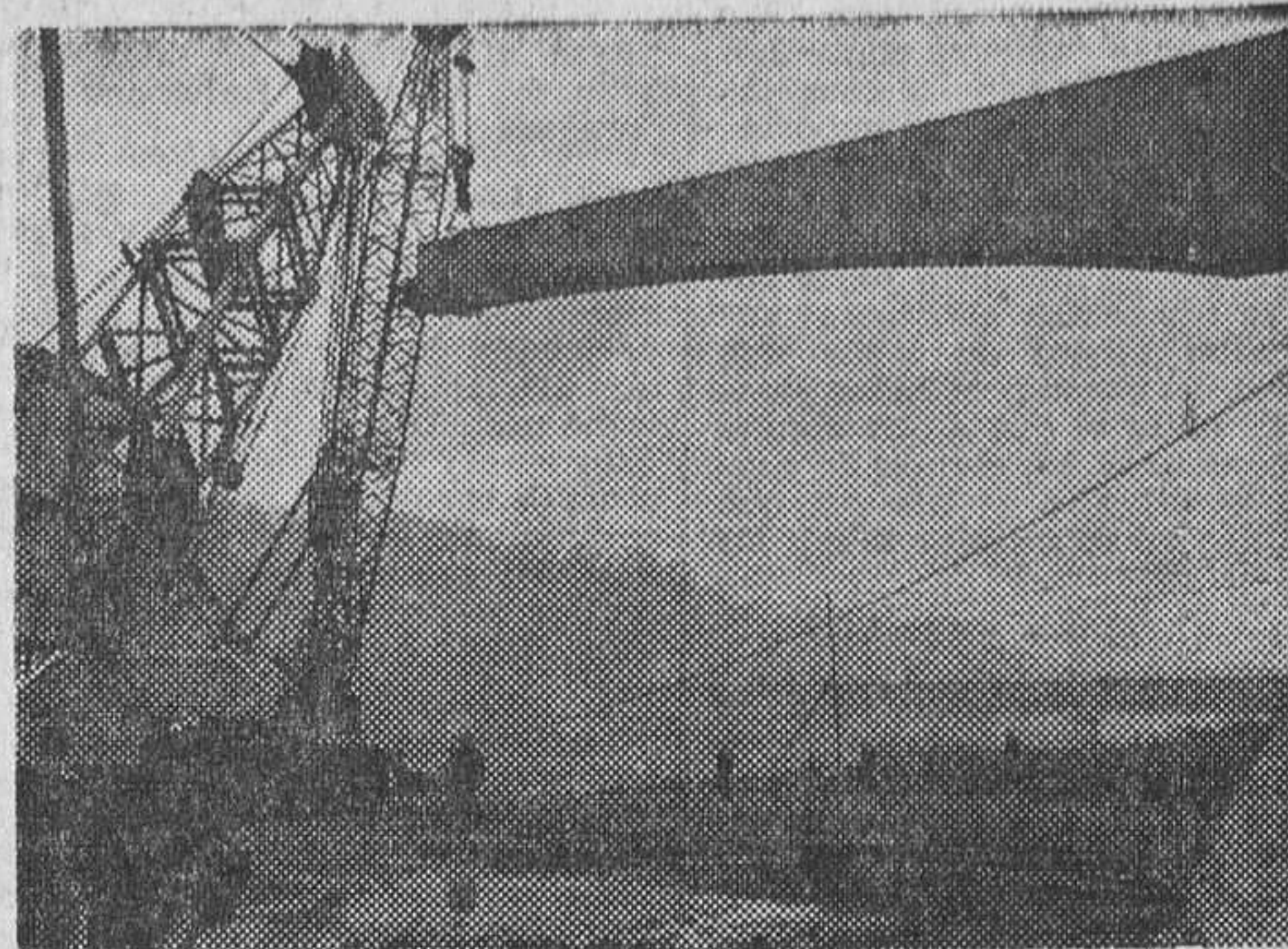
Gerona. — Momento de la colocación de la primera de las cinco vigas de que consta la armazón principal del nuevo puente sobre el Ter, que, a la entrada de esta ciudad, se halla en curso de construcción. Cada una de dichas vigas pesa noventa toneladas. (Foto Cifra.)
