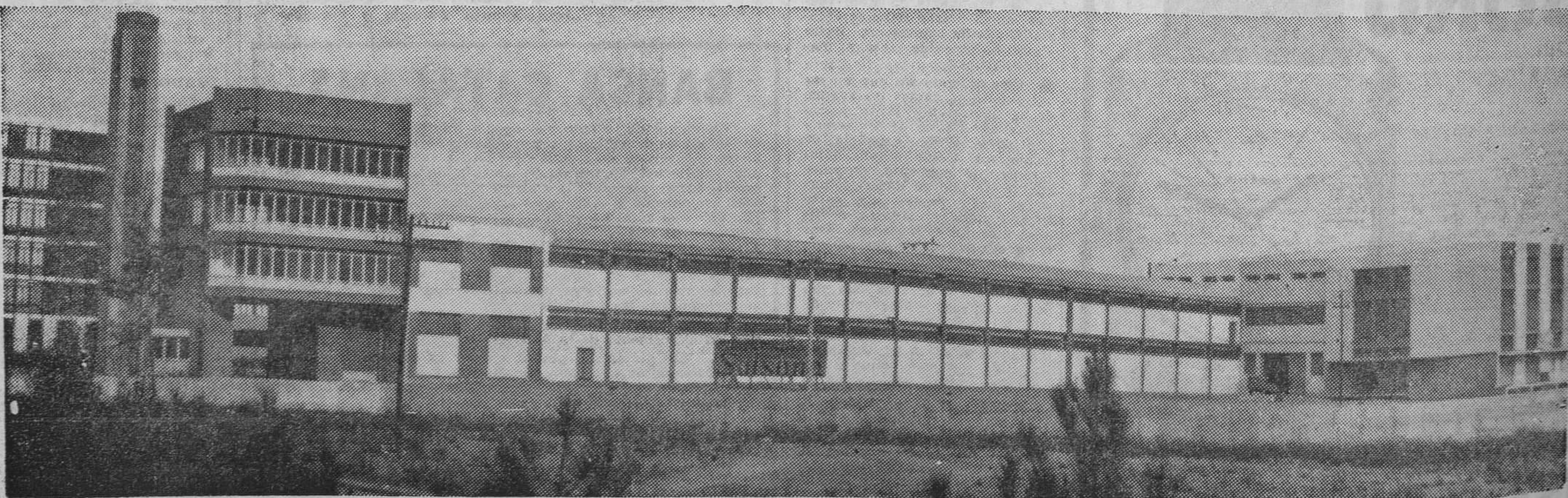
Vista parcial de una de las modernísimas factorías SOLSONA,
