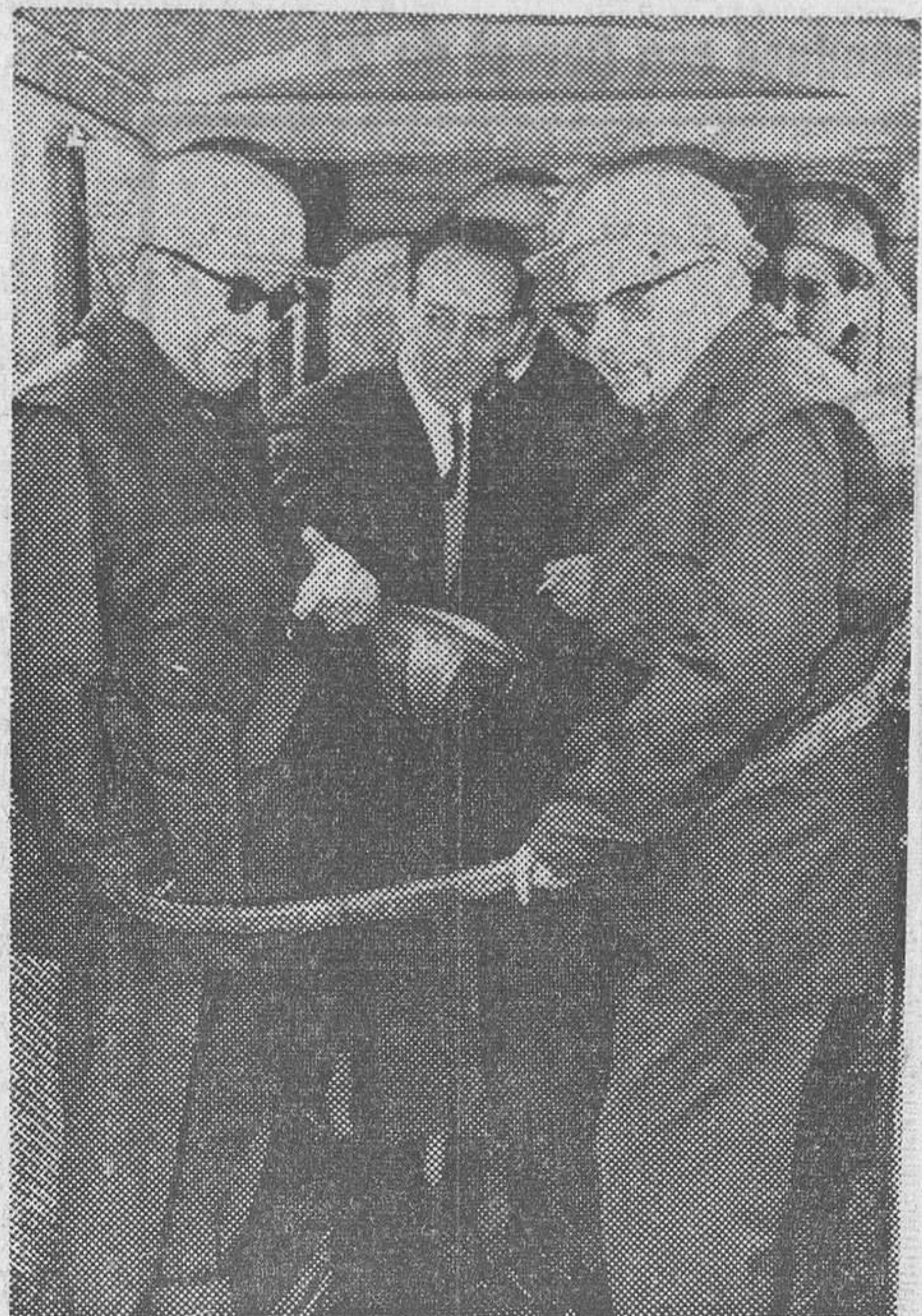
El ministro de Obras Públicas, con el gobernador civil de Barcelona y el ingeniero señor Compte, desciende en un ascensor hasta el túnel de la nueva conducción de aguas a Barcelona, en el ataque 54 de las obras, situado en La Roca del Vallés. (Foto Soterías)
