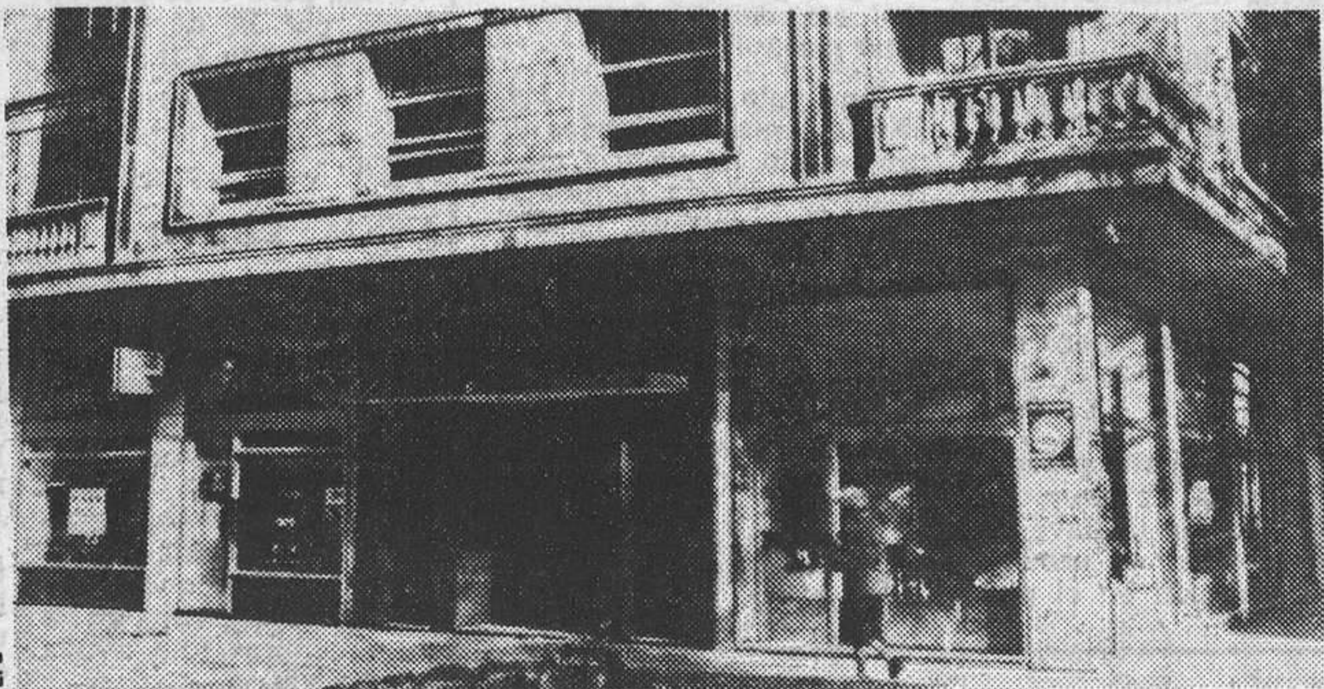
Este es el edificio que alberga a la jefatura del sector aéreo de San Sebastián
