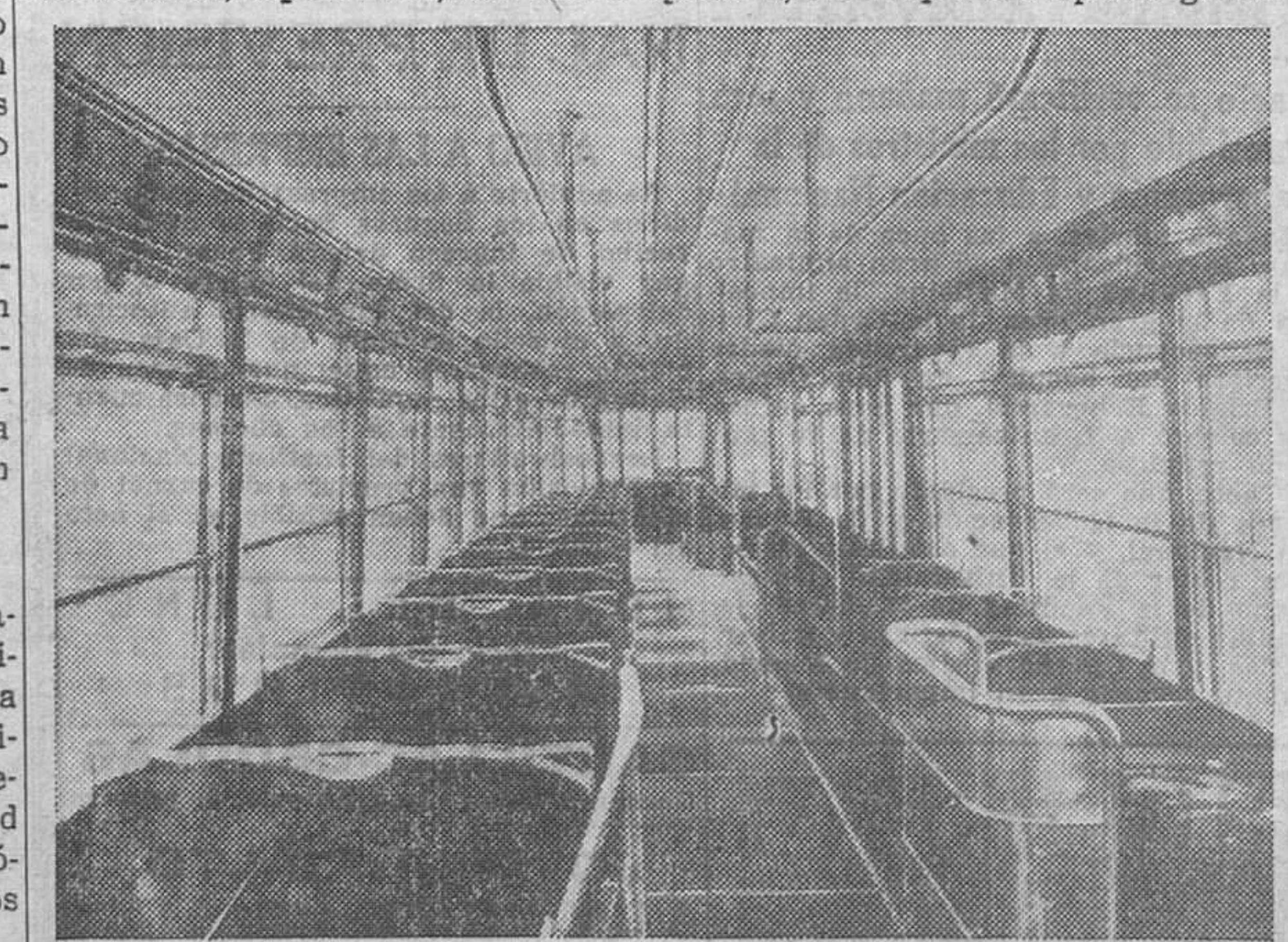
Vista del interior de los tranvías que pronto rodarán en Madrid.
