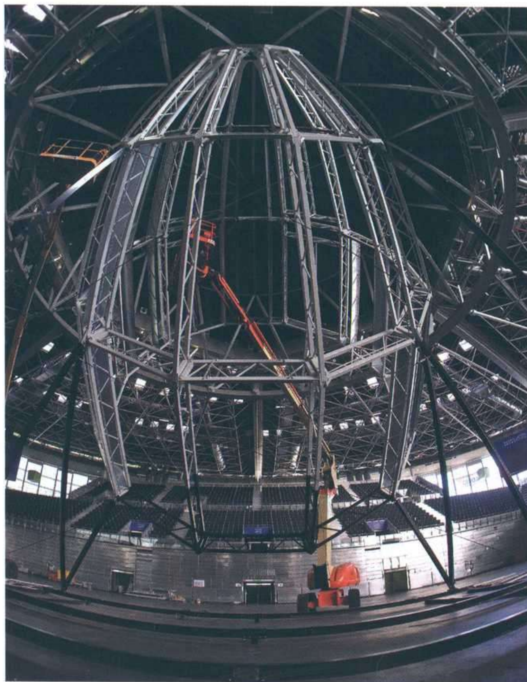
En el momento de la redacción de estas líneas se está empezando a montar la gran cúpula en el recinto de Madrid Arena.
