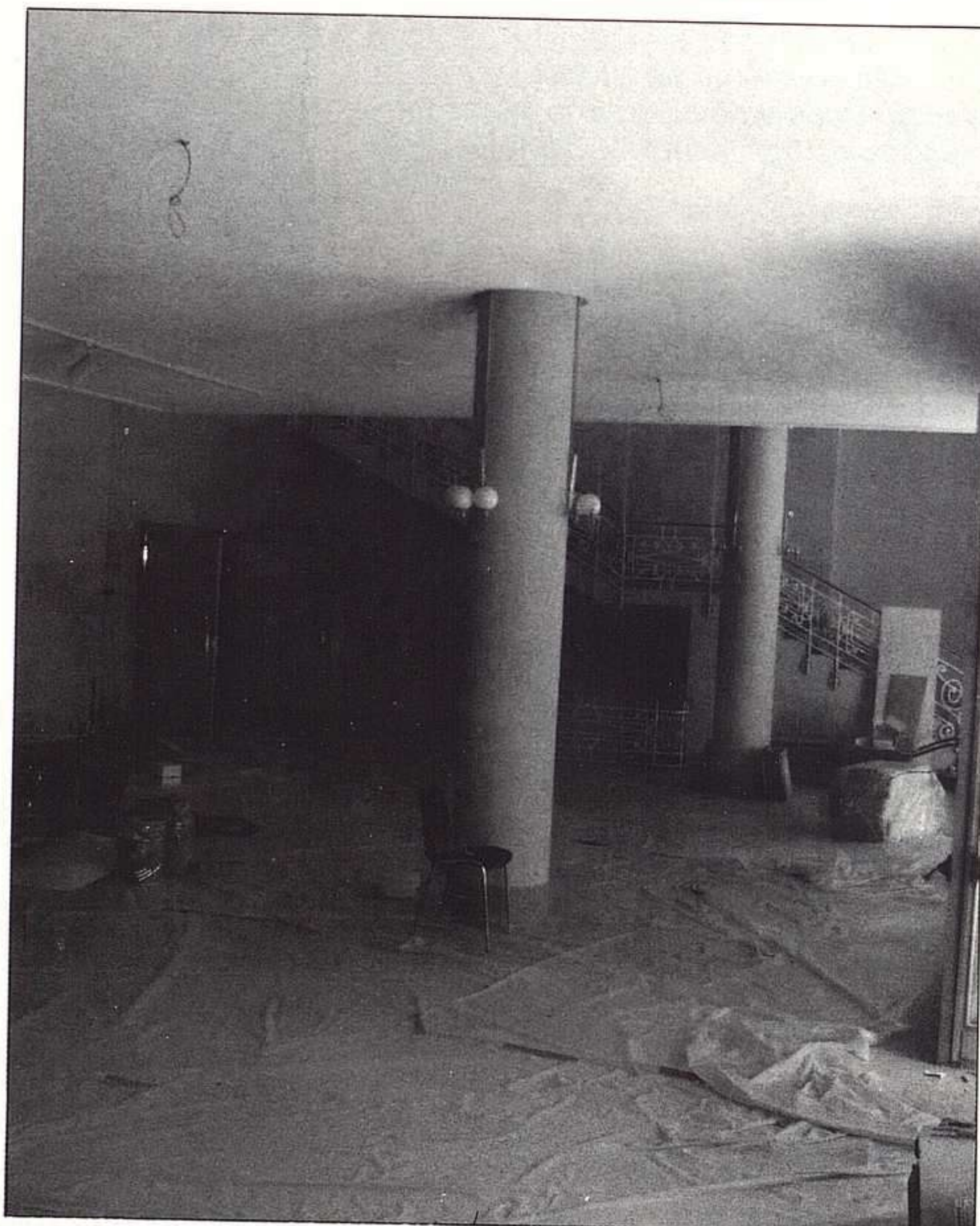
Aspecto del vestíbulo en un momento de las obras de remodelación.
