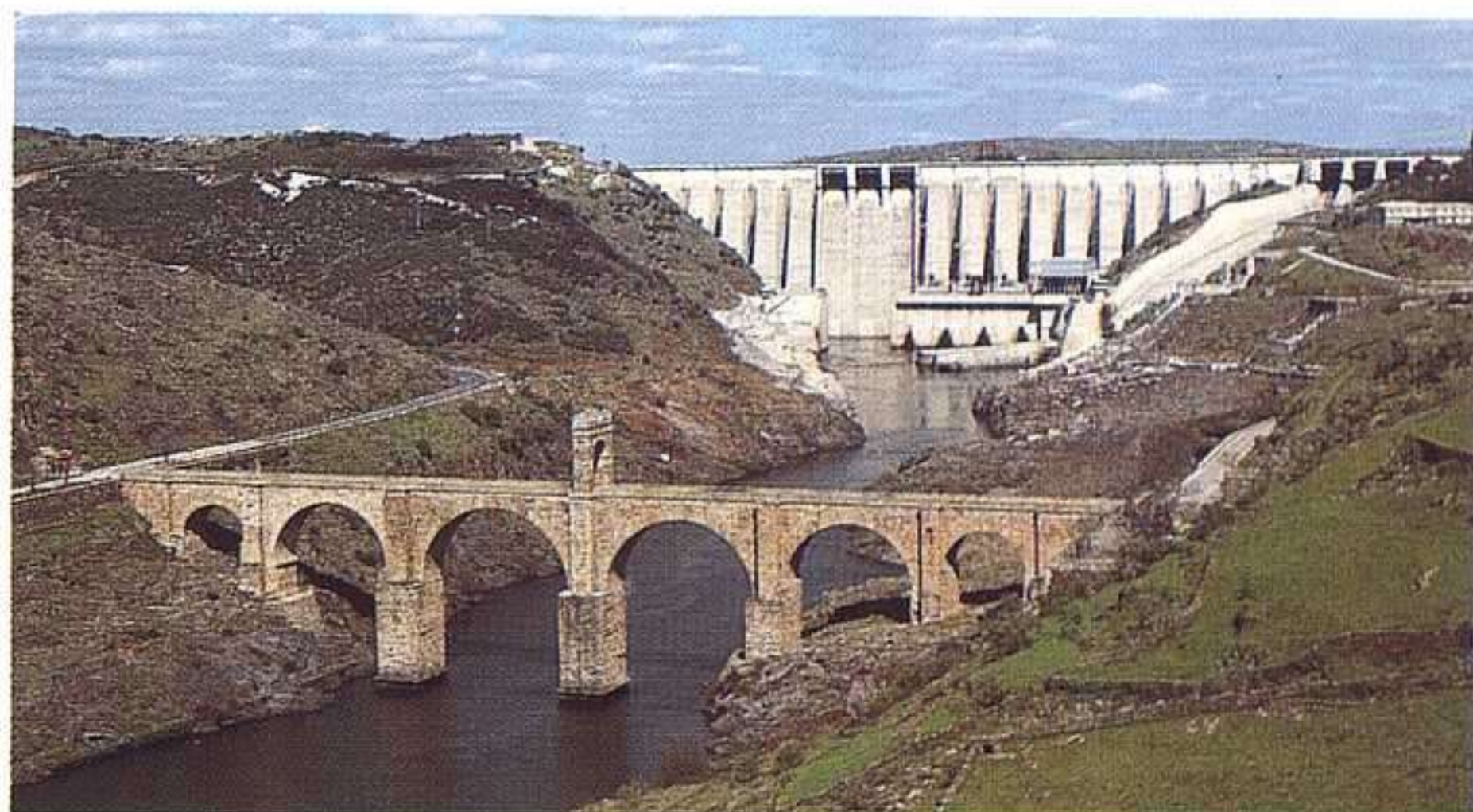
La recuperación del puente de San Benito de Alcántara se remonta a los comienzos de Hidrola. En las fotos, vistas del Puente y el Monasterio.
