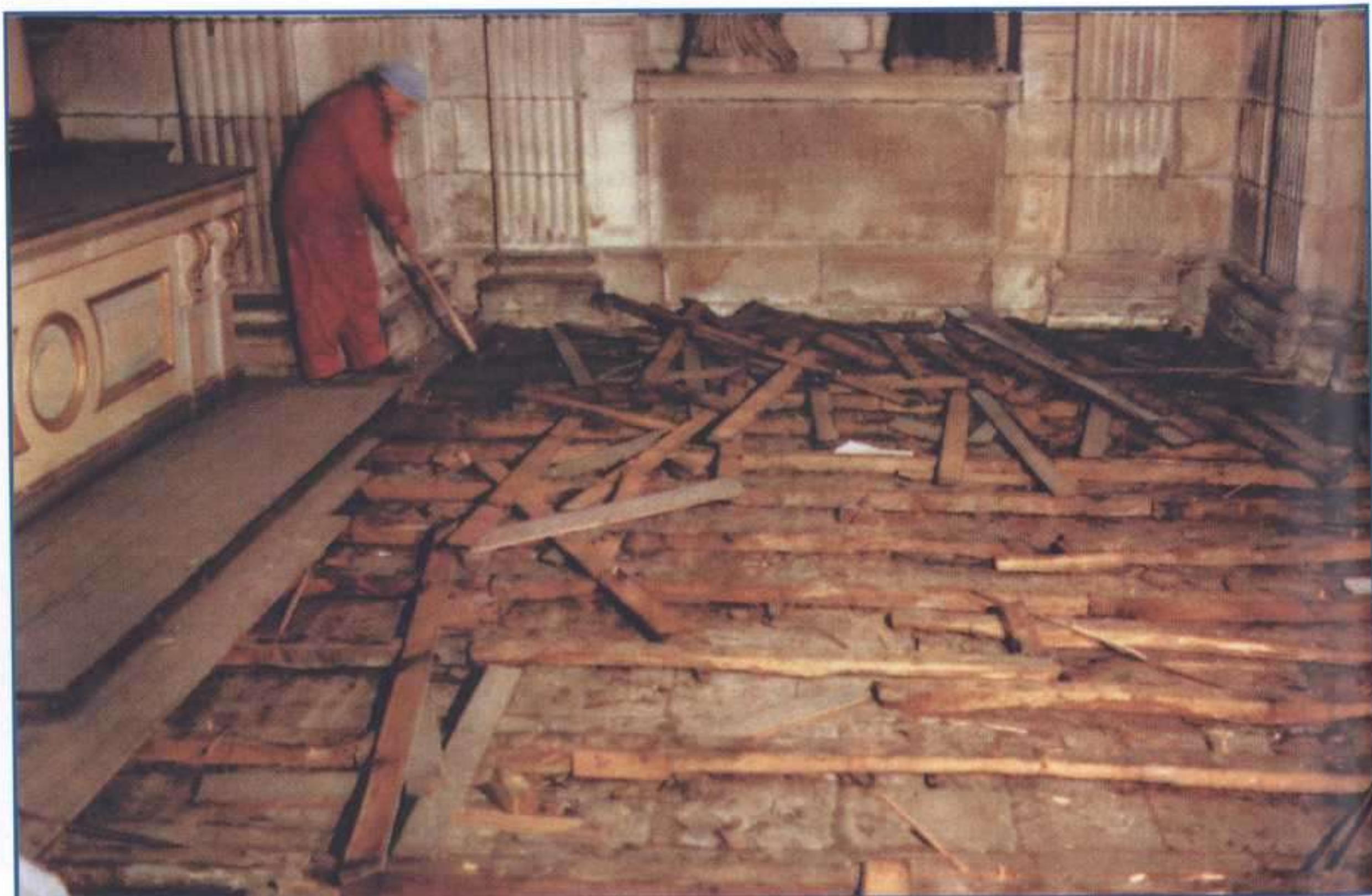
Imagen de una de las fases de los trabajos de restauración de la Iglesia de la Universidad
