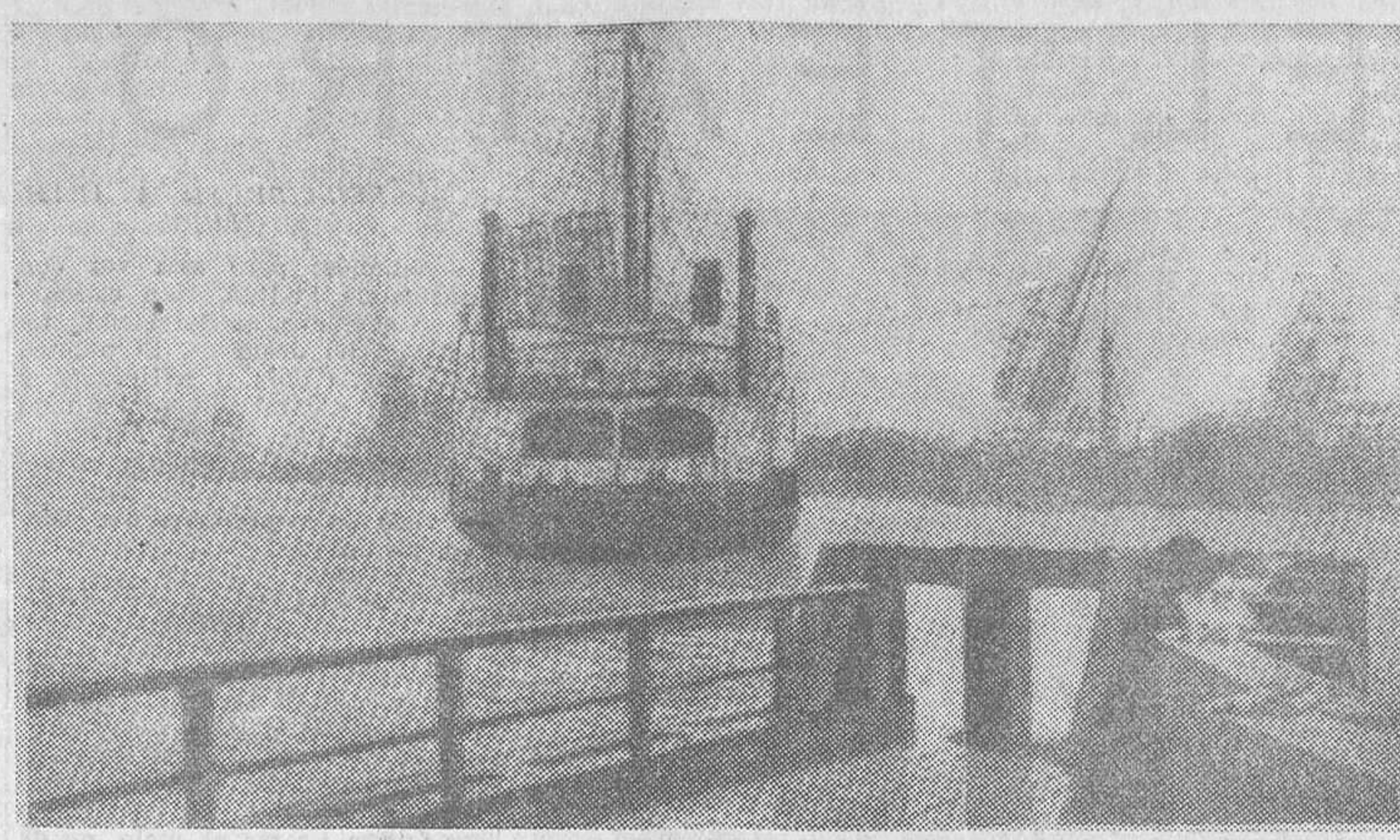
Tanto en Dunkerque como en Douvres han terminado las obras de los muelles para el atraque de las embarcaciones, que permitirán realizar el viaje desde París a Londres sin abandonar el cómodo vagón del ferrocarril. Este atravesará el canal de la Mancha en embarcaciones como el «Shepperton Ferry», llegado a Dunkerque para hacer las pruebas de atraque
