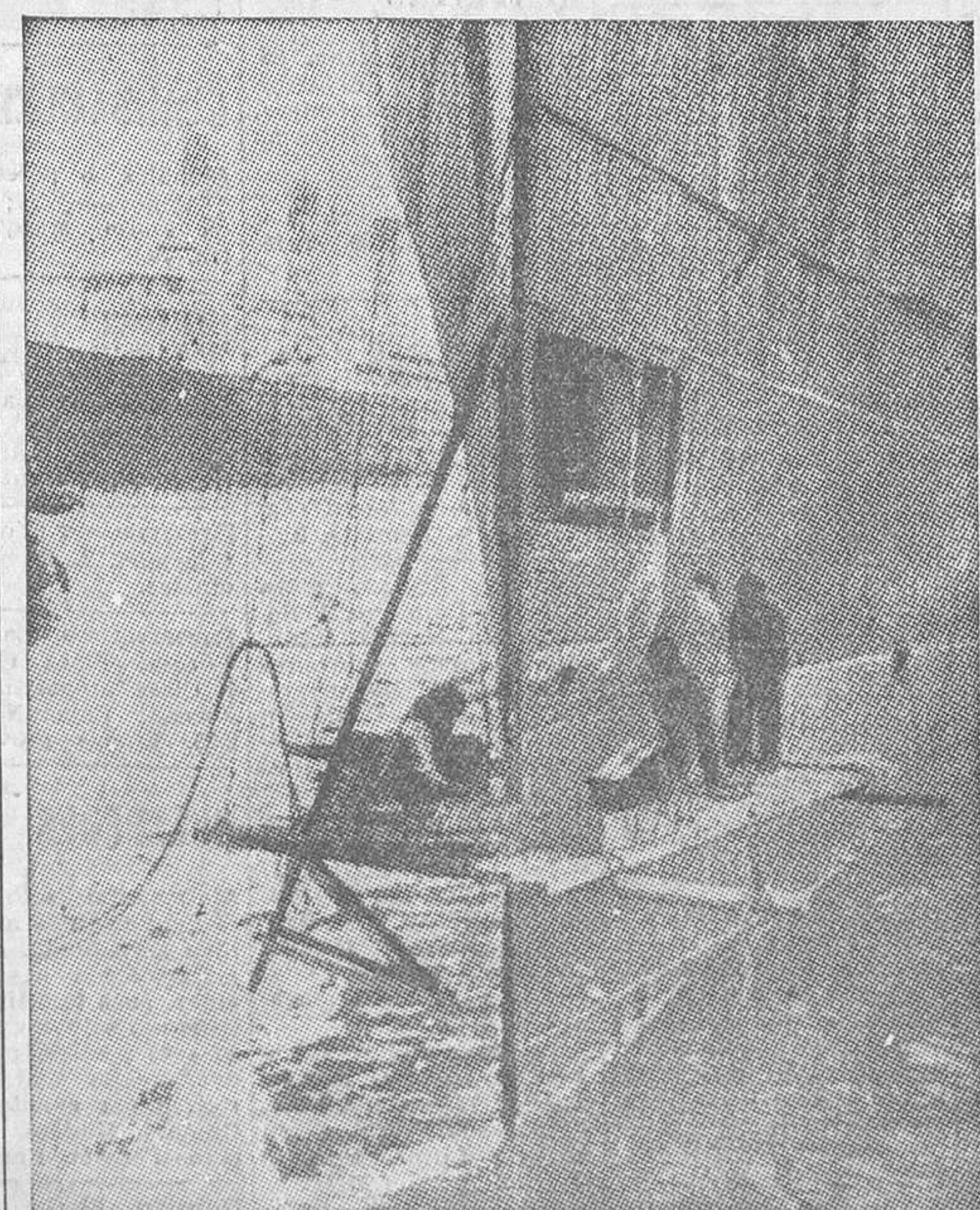
El «Olympic», magnífico transporte inglés, ha necesitado que se le coloquen nuevas planchas de acero, a causa de las averías sufridas al organizar el salvamento de otro barco en peligro de naufragar.
