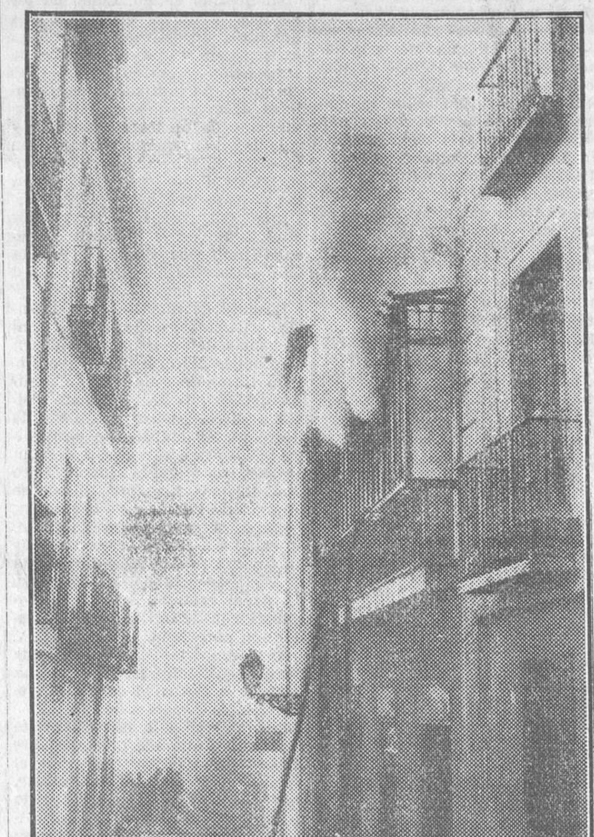
Incendio de la casa núm. 6 de la calle del Nuncio, donde el fuego que se declaró en una fábrica de bisutería causó grandes destrozos (Fot. Alfonso.)
