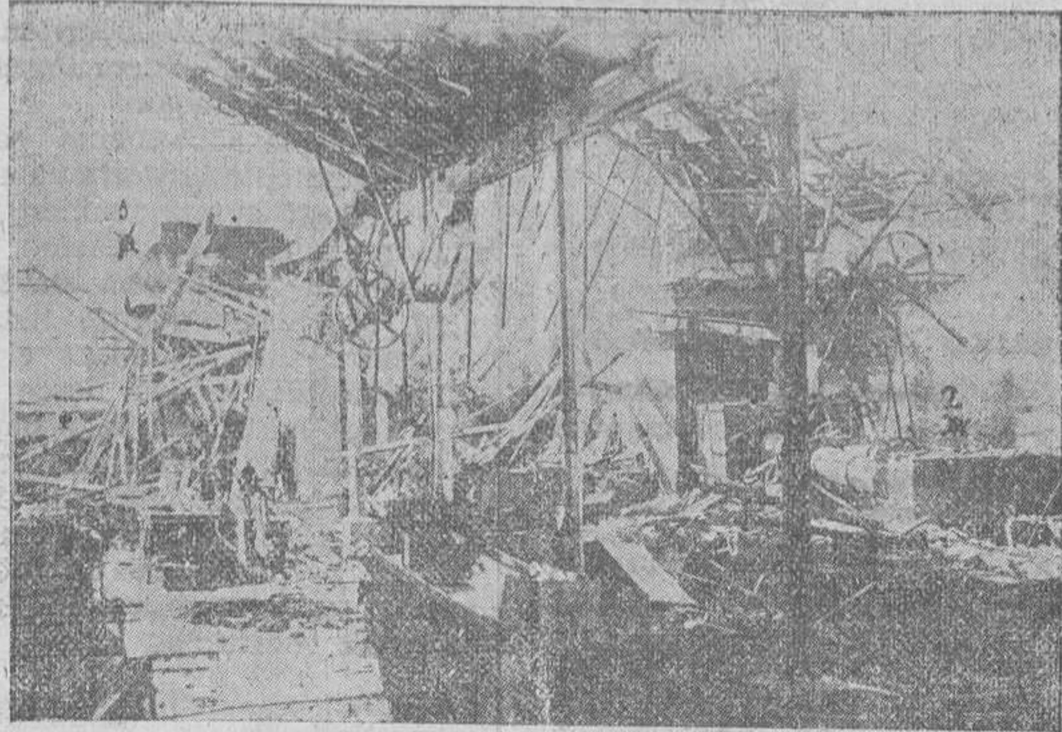
Vista total de la fábrica después de ocurrir la catástrofe. El punto y cruz señalado con el número 1, es la pared medianera de la casa de Concepción Rubio, derrumbada, donde halló muerte, entre los escombros, el niño Vicente, y heridas graves su madre. El punto y cruz número 2, indica el sitio en que estuvo emplazada la caldera.
