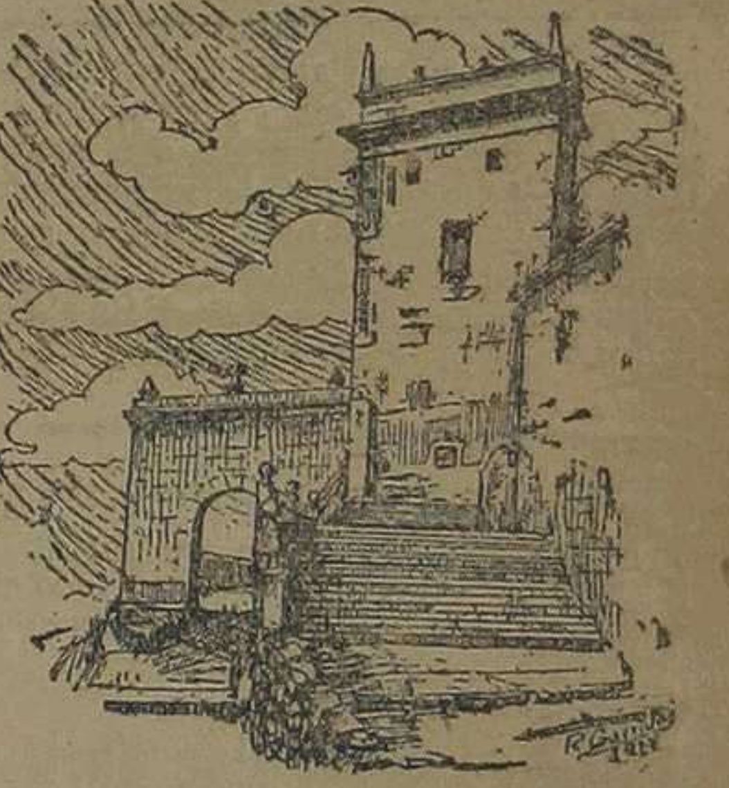
Puerta del baluarte y torre del Noreste
