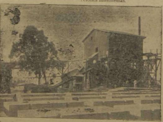
La hormigonera.—Máquina ingeniosamente combinada para la obtención de los bloques de hormigón que se emplean en la construcción de monolitos
