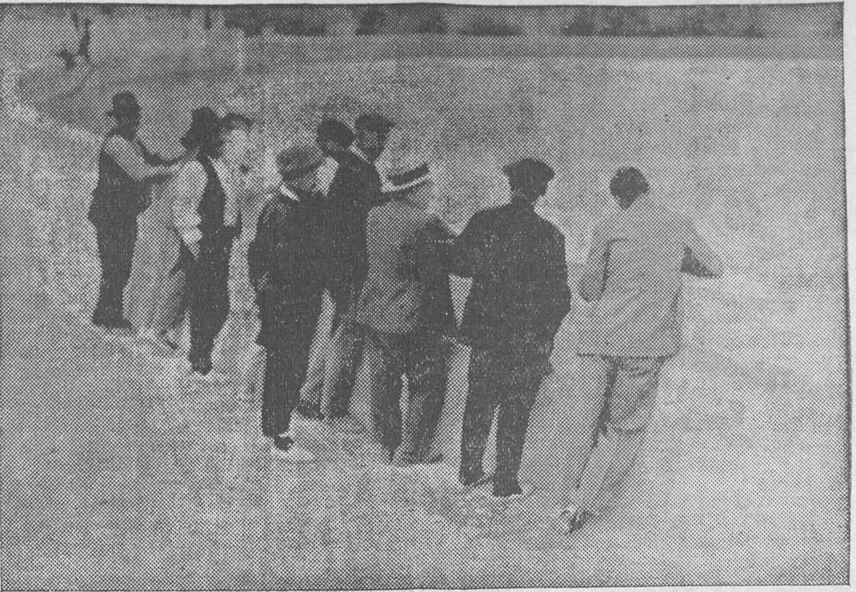
UNA VISTA PARCIAL DEL TANQUE REGULADOR A 57 METROS SOBRE EL NIVEL DEL POZO DE CONDUCCION
