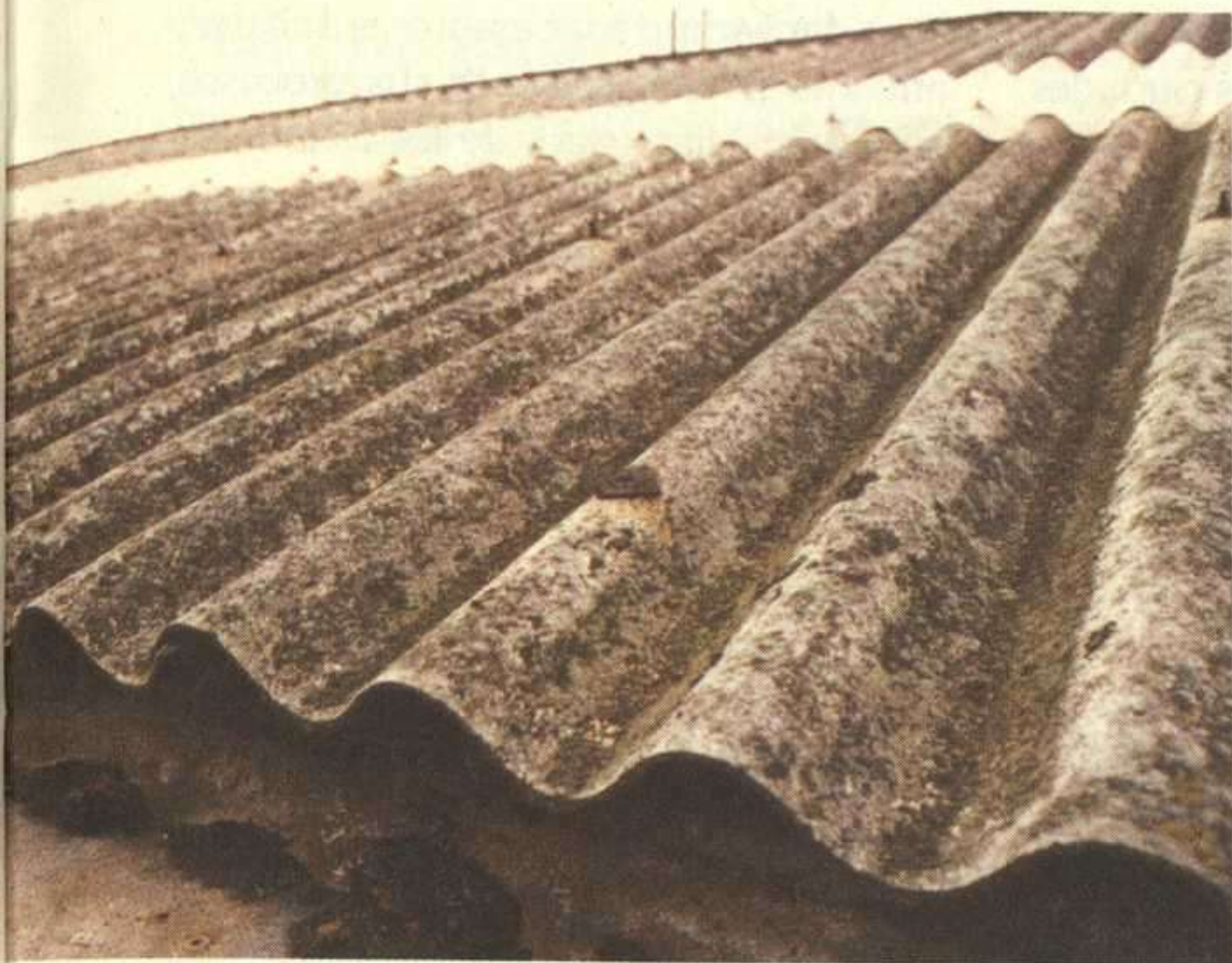
Los tejados de amianto-cemento son muy frecuentes.
