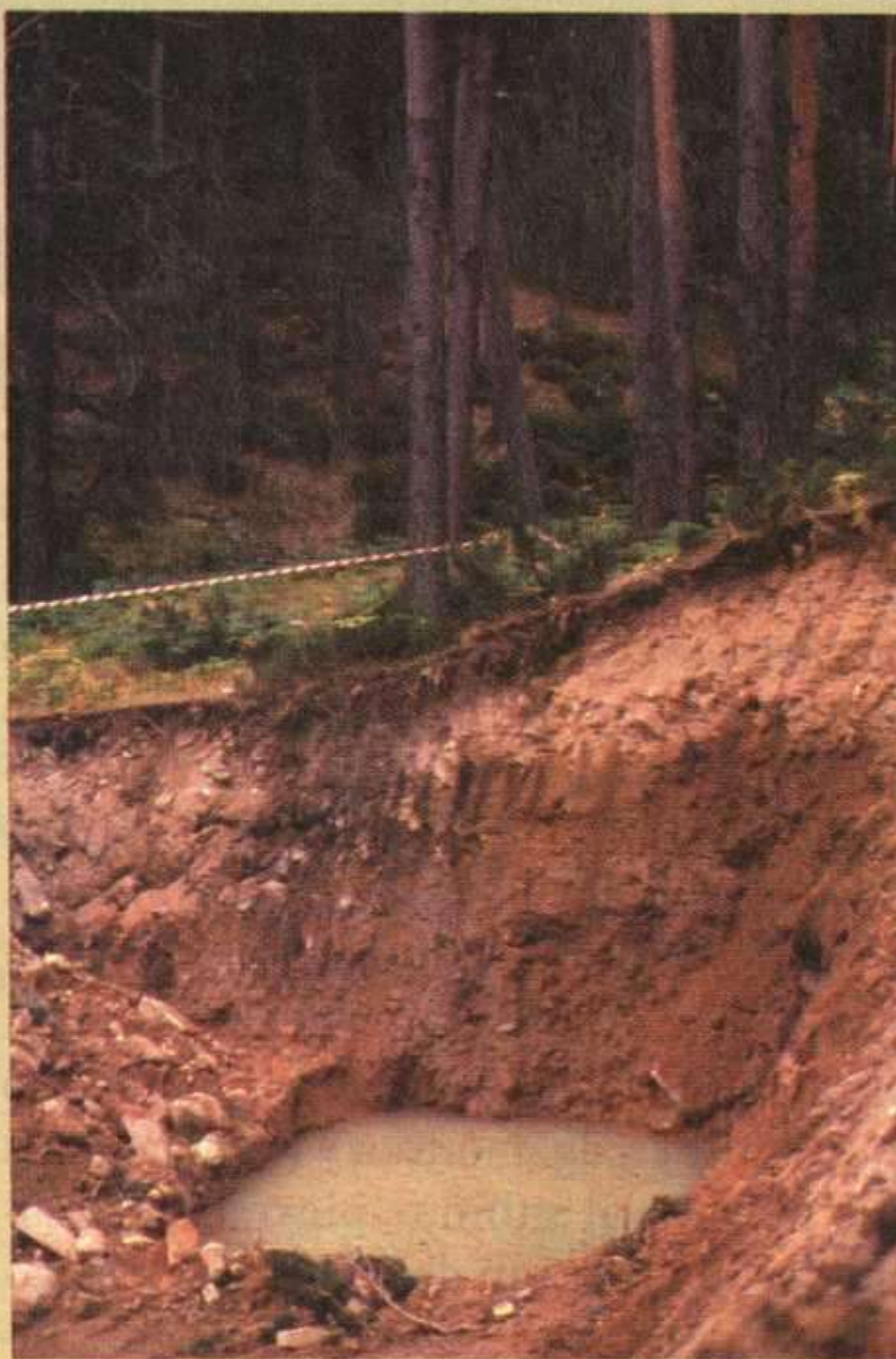
Obras de azud en el Telégrafo.
