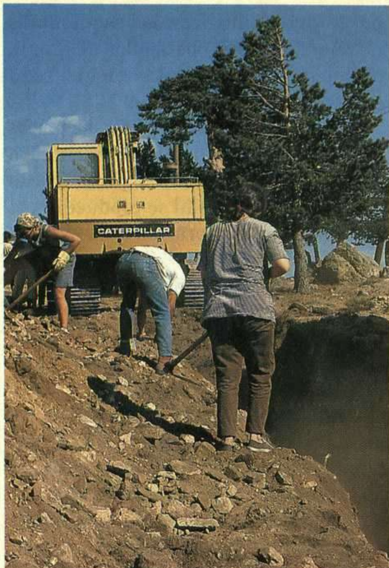
Acción ecologista, rellenado de zanjas
