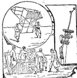
A la derecha, el aparato en pleno vuelo; á la izquierda, el lanzamiento, y abajo, la cabria á que está sujeto el cable.
