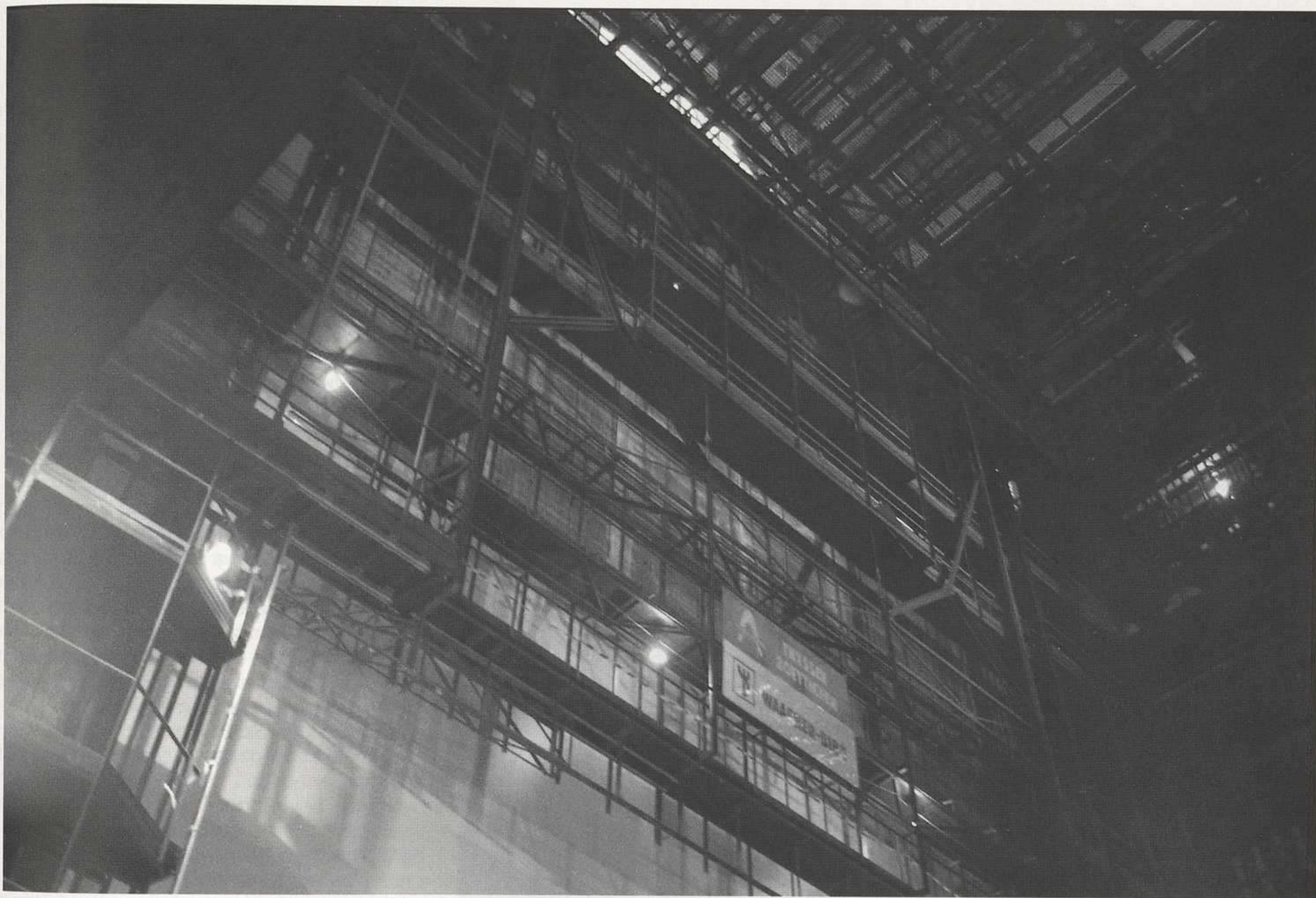
Una imagen de las obras interiores del Teatro Real de Madrid. (Junio 1994). (Foto: EdeláE López).
