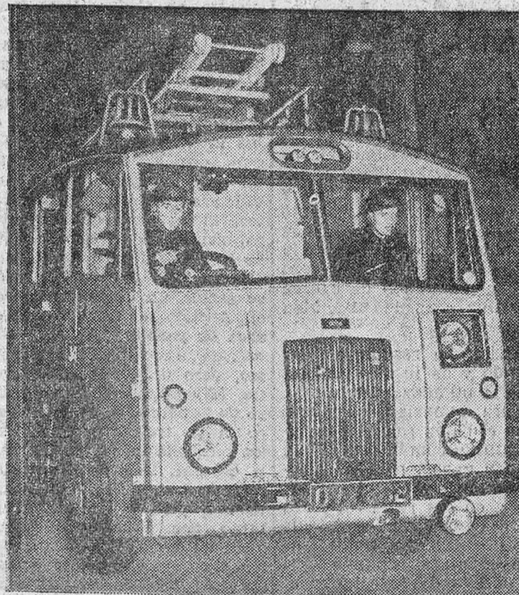
Modelo moderno y veloz de coche-bomba para bomberos, motor "Roll-Royce" de 160 caballos, con departamento cerrado y cabina para seis hombres, que pueden ir vistiéndose durante la marcha del vehículo hacia el lugar del siniestro.
