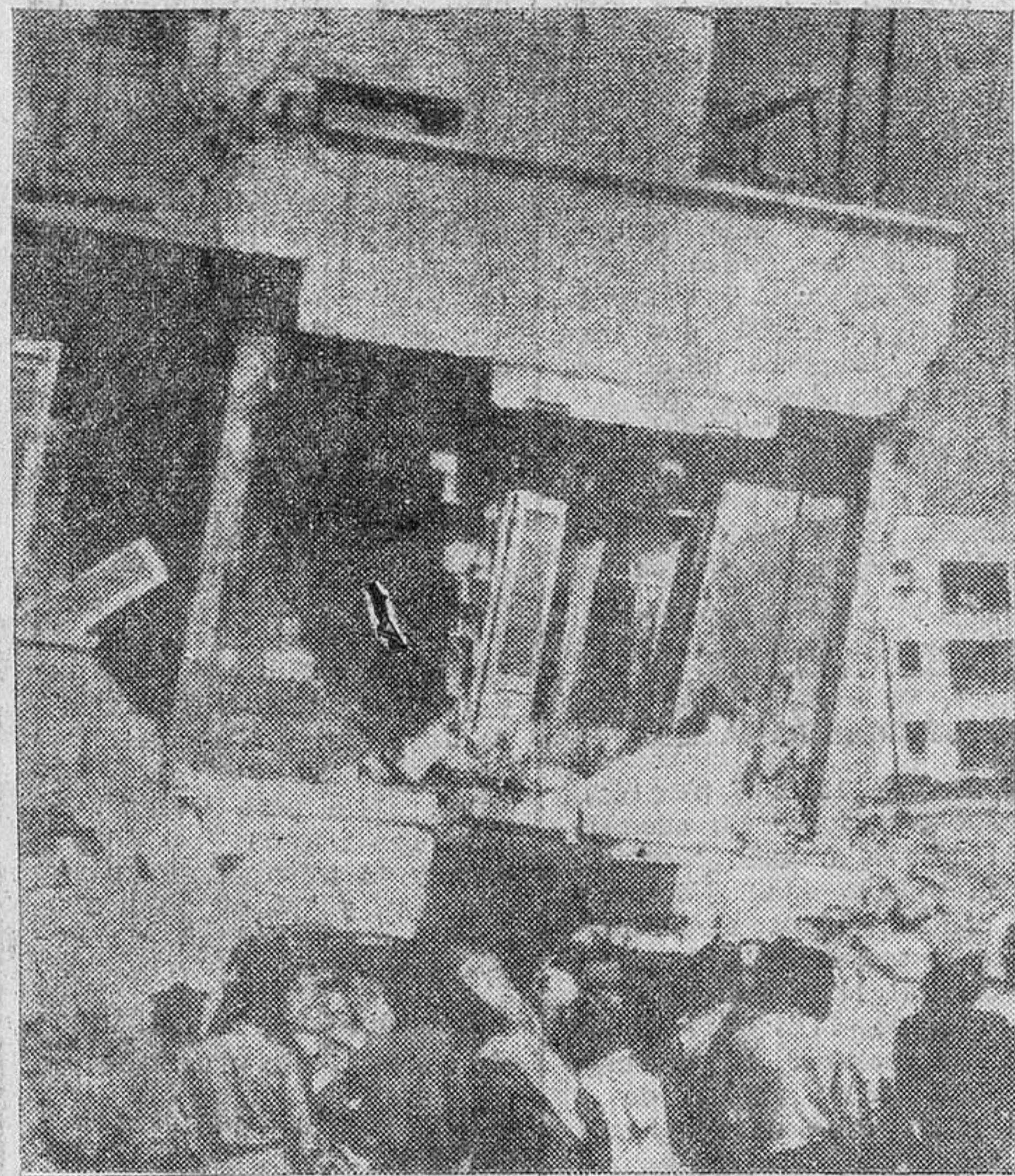
Una trágica estampa de uno de los barrios de Agadir. Edificios destruidos, muros amenazantes aún, enormes zanjas abiertas, por la furia del terremoto, se ofrecen por doquier. En franco abrazo, militares y civiles, musulmanes y europeos, trabajan sin cesar buscando entre los escombros las docenas de víctimas que aún se encuentran enterradas.
