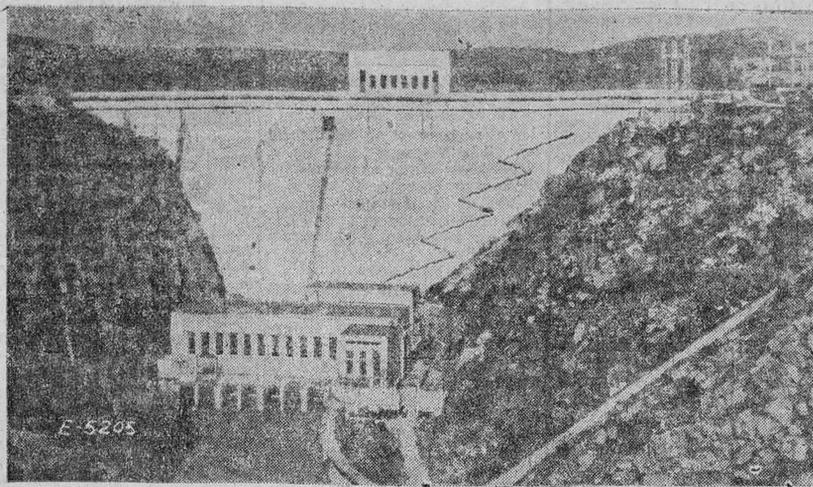
La gran presa del Salto del Salto, de 92 metros de altura, contiene un embalse de 1.200 millones de metros cúbicos. Al pie, la central con cuatro grupos generadores de potencia total de 200.000 C.V. y una producción anual de 430 millones de kilovatios-hora. (Foto Heptener.)
