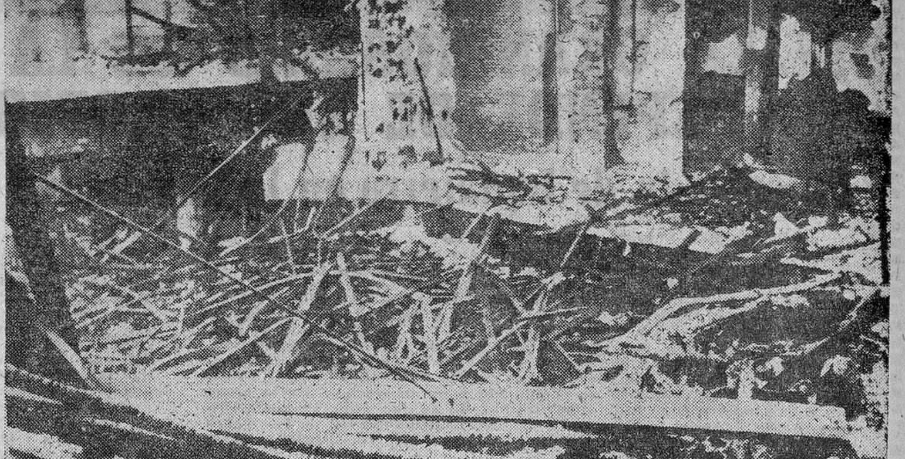
BILBAO.—Estado en que quedó el Cine Olimpia, que resultó totalmente destruido por un incendio, que comenzó en la tarde del día 17 de julio y terminó al amanecer del día 18. Este moderno local, que tenía escasos años de existencia, se encontraba en la calle Iparraguirre y había sustituido al viejo Cine Olimpia de la Gran Vía. Los daños son elevadísimos.—(Foto Cifra).
