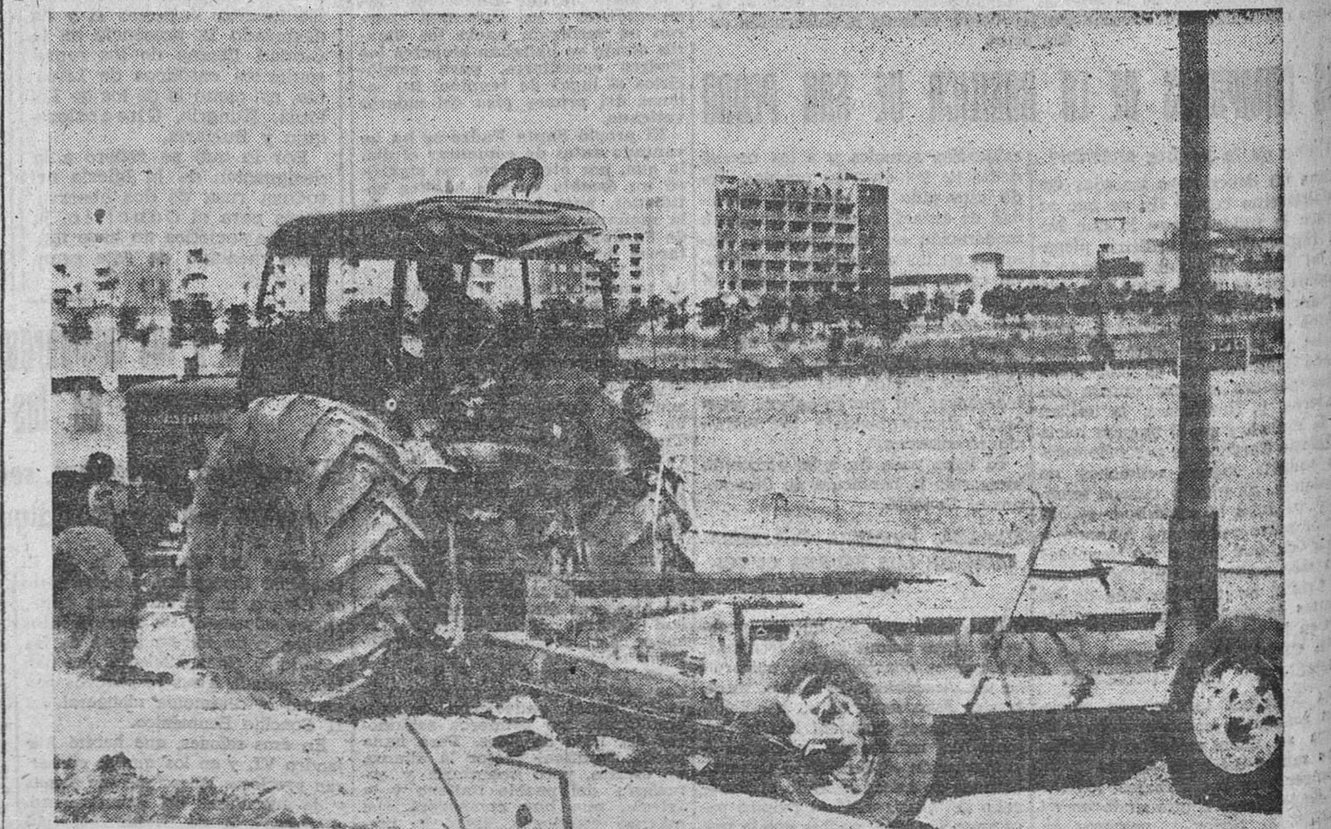
En los trabajos industriales y de obras públicas, el tractor es prácticamente indispensable. El «Hemomag Barroiros R-555» de 65 CV, por su potencia y robustez, realiza una eficaz labor en la nivelación y movimiento de tierras. He aquí uno de estos modelos realizando dicho trabajo con tralla. (IBERFOTO).
