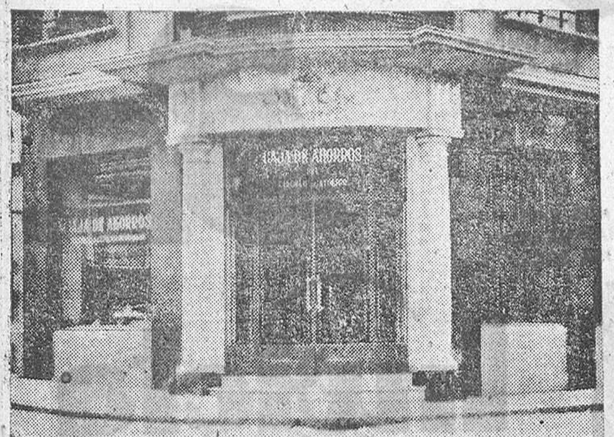
Fachada de la Sucursal Urbana número 1, sita en la travesía del Hondillo, después de las obras de reforma.
