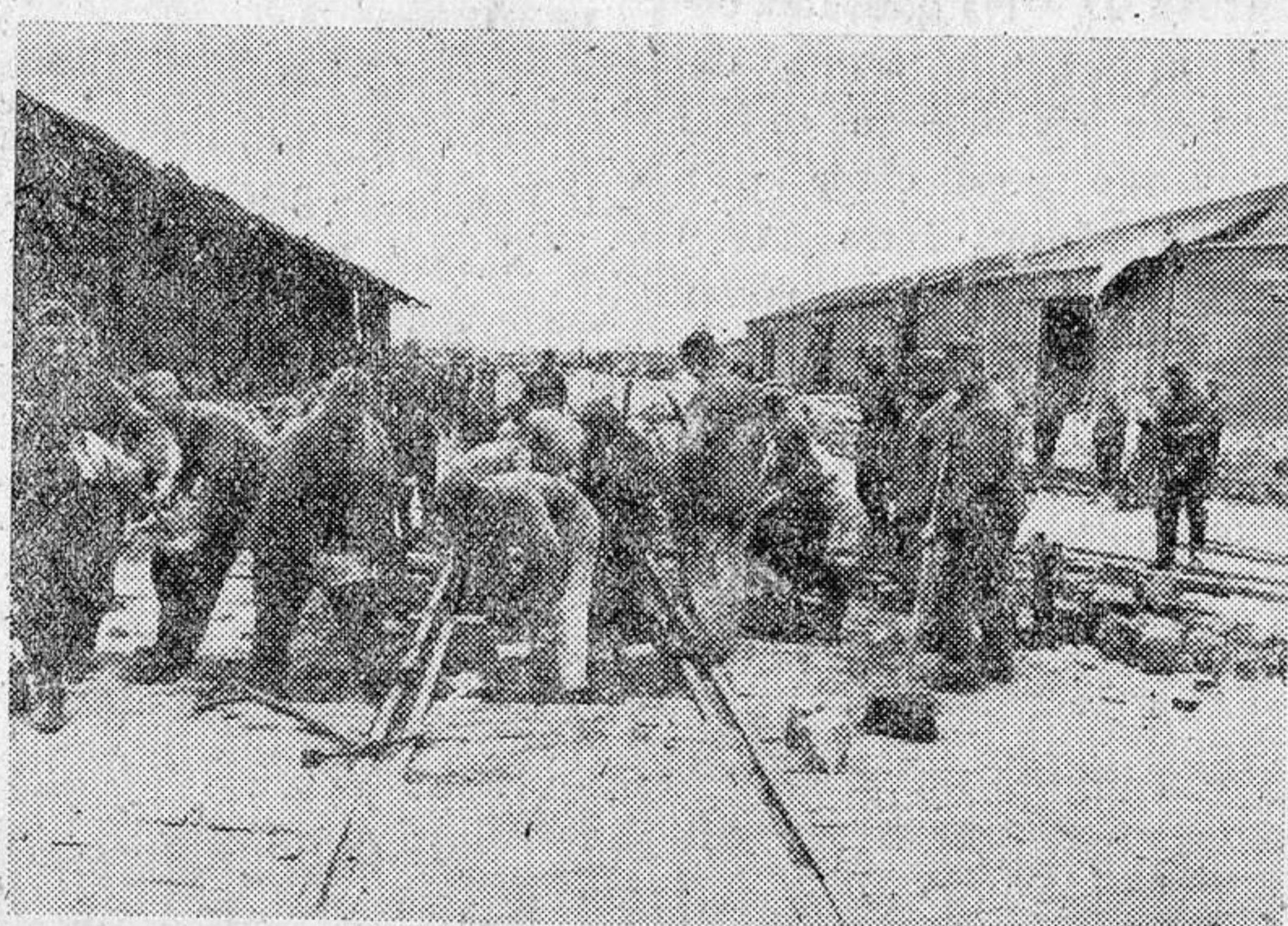
Gastadores alemanes reparando las vías ferroviarias de la costa de Flandes.
