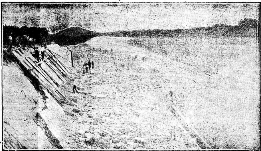
Contrata del señor Corbí. Explanada de la Estación de Bullas en el F. C. de Fortuna a Caravaca; a la izquierda un muro de revestimiento de 6 metros de cota. Trozo 3.º de la Sección 3.ª
