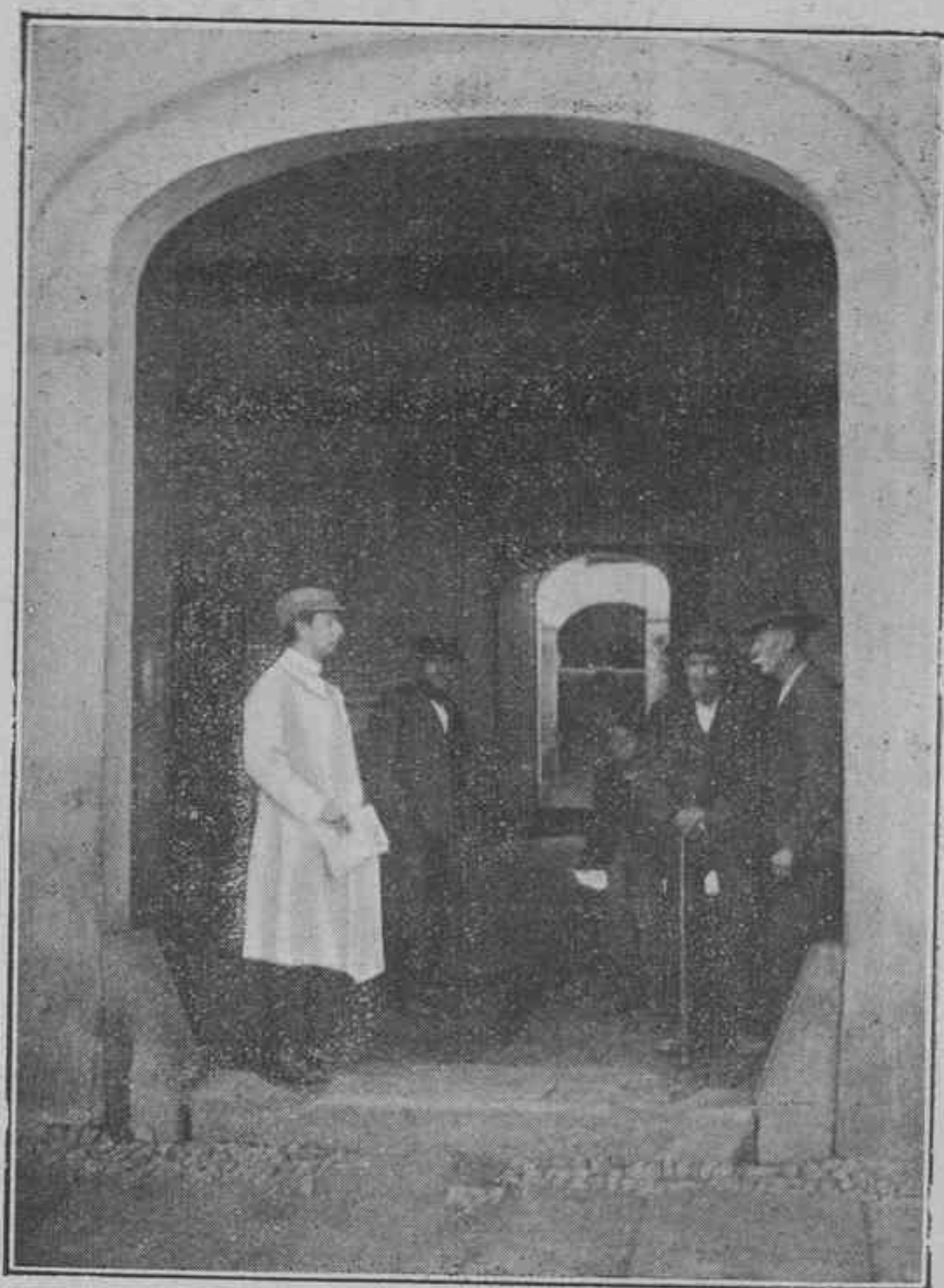
Entrada a la Clínica.
