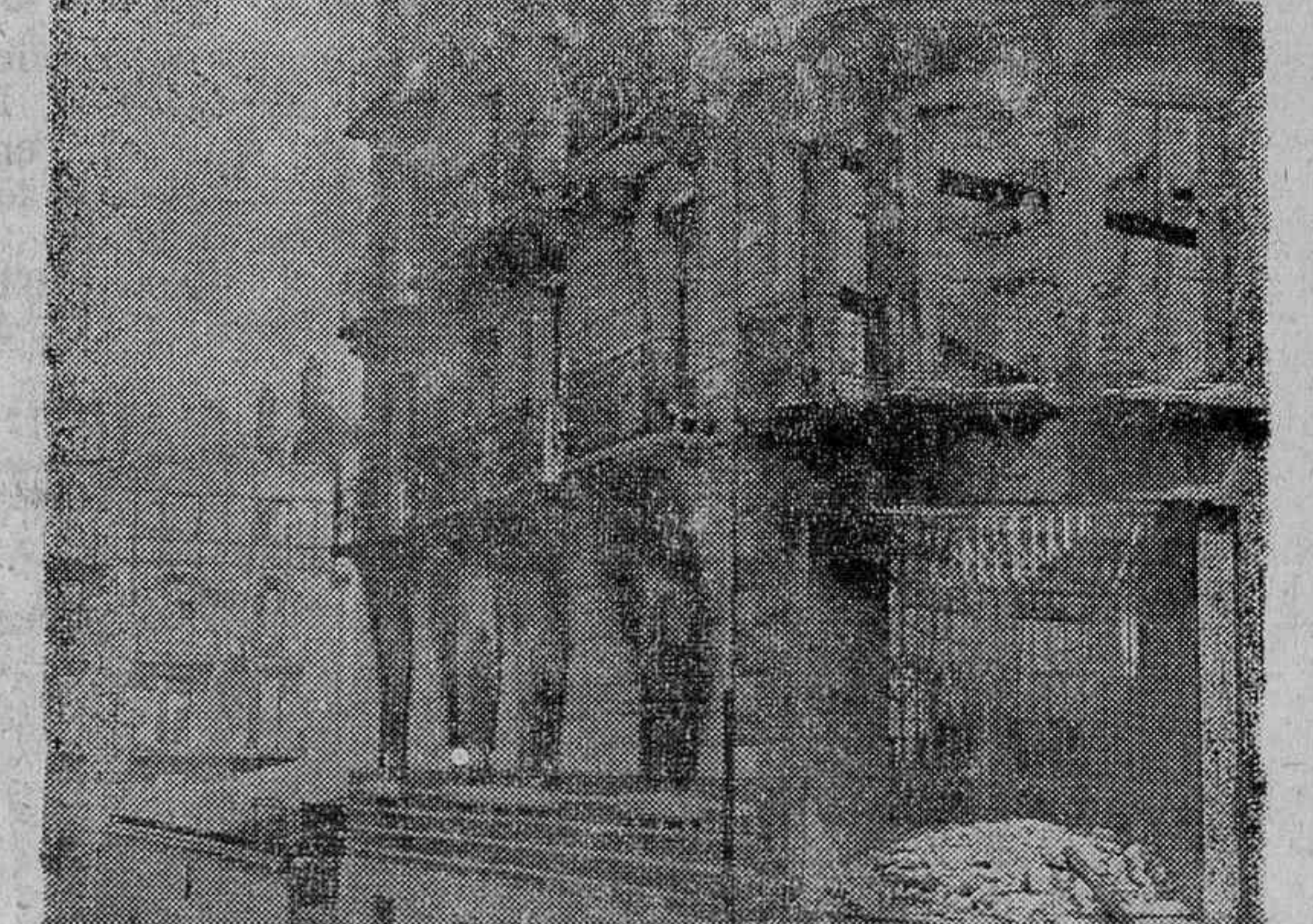
En cualquier calle de Irún, el aspecto es el mismo. De las casas solo quedan los muros (Foto Luis Alfaro.)
