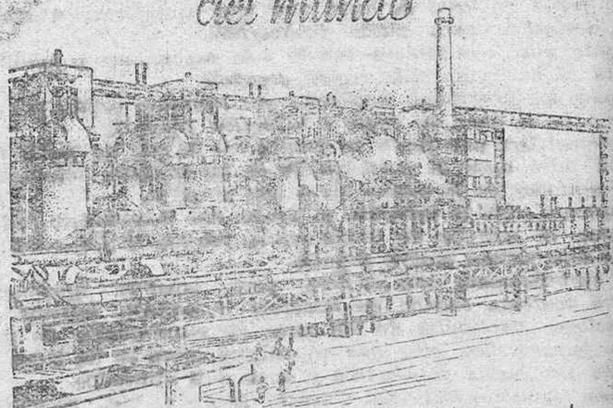
de destilación de hulla, para la fabricación de gasolina sintética, de más de 1.500.000.000 de m.<sup>3</sup> teóricos de gas sintético de capacidad, fué construida por la casa KOPPERS de Essen (Renania), según sistema de Fischer-Tropsch. Esta instalación consta de siete instalaciones de las que solo cinco se ven en la figura.
