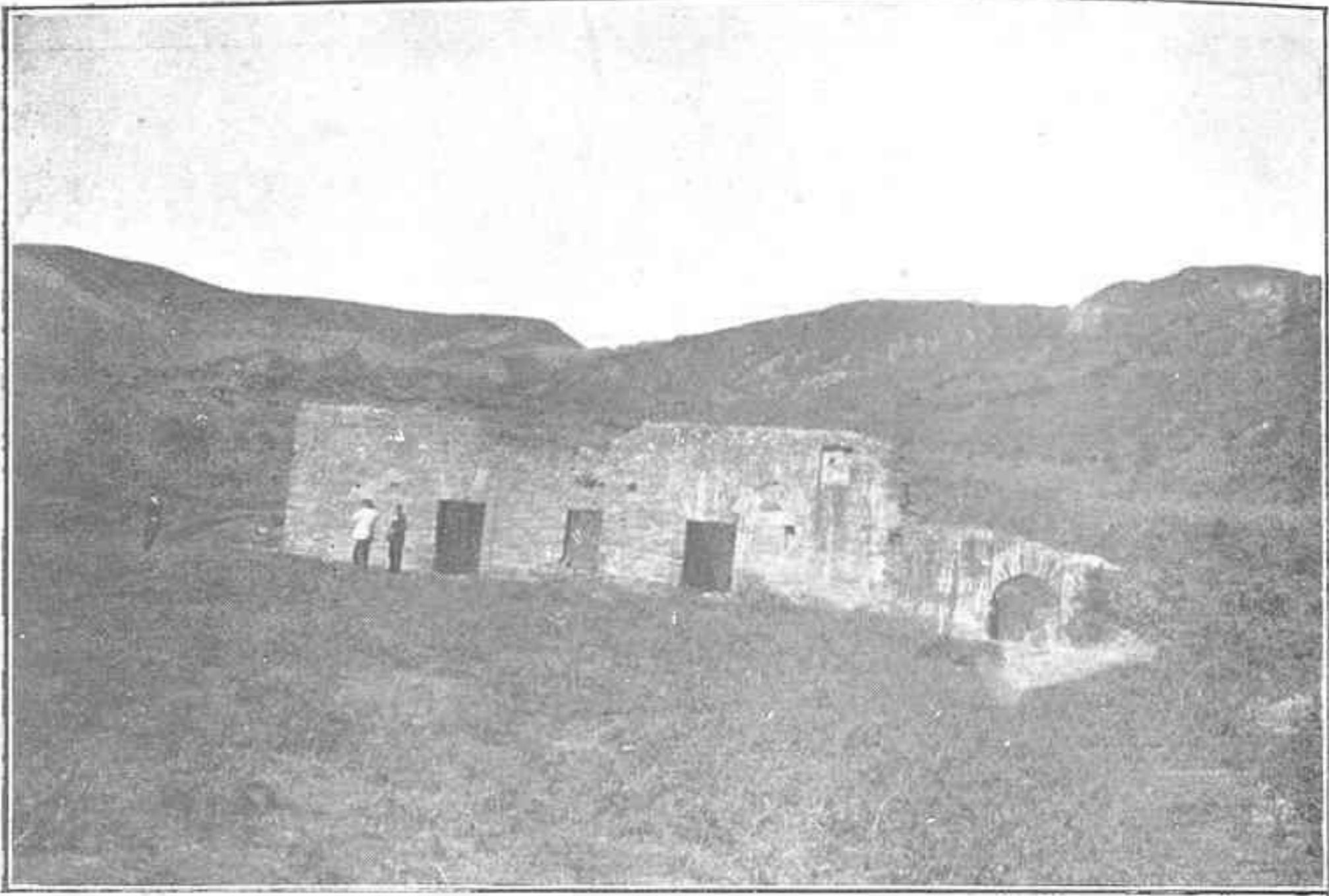
Fábrica de hierro de La Somoza. (Vista general de la fachada, con la entrada al departamento de máquinas hidráulicas.)
