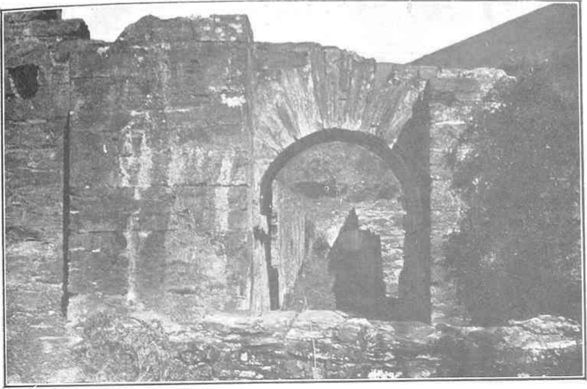
Fábrica de hierro de La Somoza. (Entrada al departamento de ruedas hidráulicas.)
