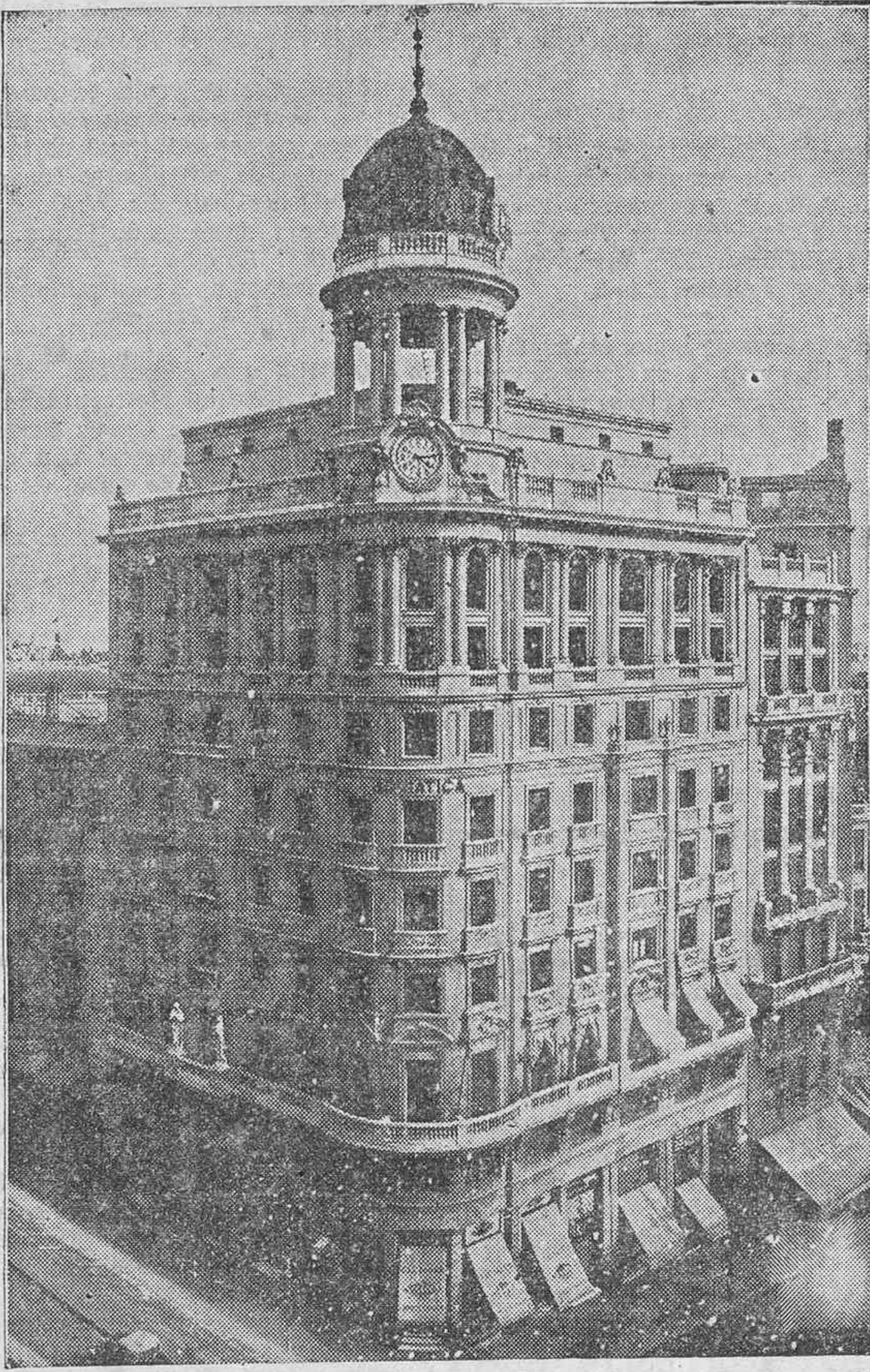
Aspecto general del edificio emplazado en la Gran Via (Avenida de Pi y Margall, 17) y Plaza del Callao en Madrid. Inspector general para Canarias de los Ramos de Vida y Transportes: AURELIO MATOS CALDERON SANTA CRUZ DE TENERIFE.
