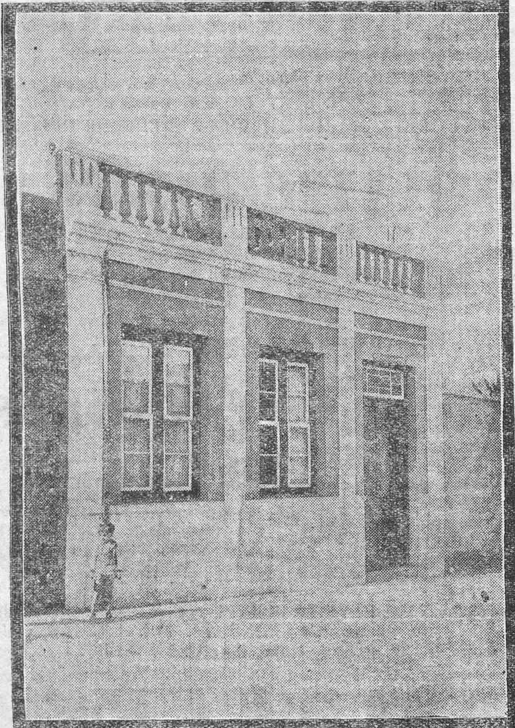
Casa construida en la calle Carretas de La Laguna por el socio del Banco Hispano de Edificación don Domingo Alvarez González, con capital facilitado por dicha Entidad. El señor Alvarez abona mensualmente al Banco Hispano de Edificación cuarenta y dos pesetas setenta céntimos, incluida en esta cantidad amortización de capital e interés que es tan sólo de dos pesetas diez céntimos anuales por cada cien recibidas.
