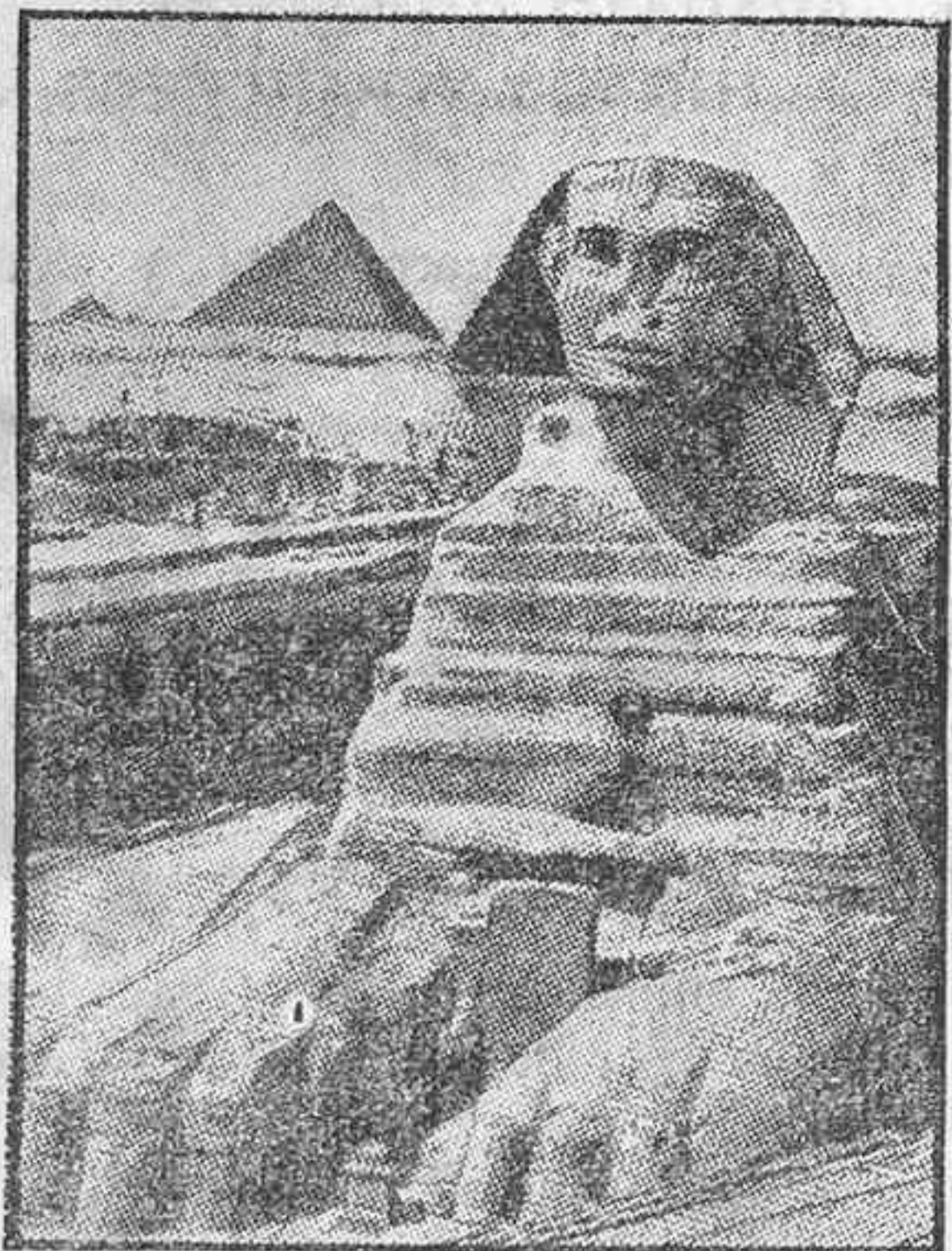
El famoso monumento de la Esfinge, en Egipto, que a causa de unas antiguas grietas se halla amenazado de derrumbarse. Ya en 1925 se procedió a repararlo, pero suspendida la obra ha vuelto a reproducirse el peligro con mayor gravedad.
