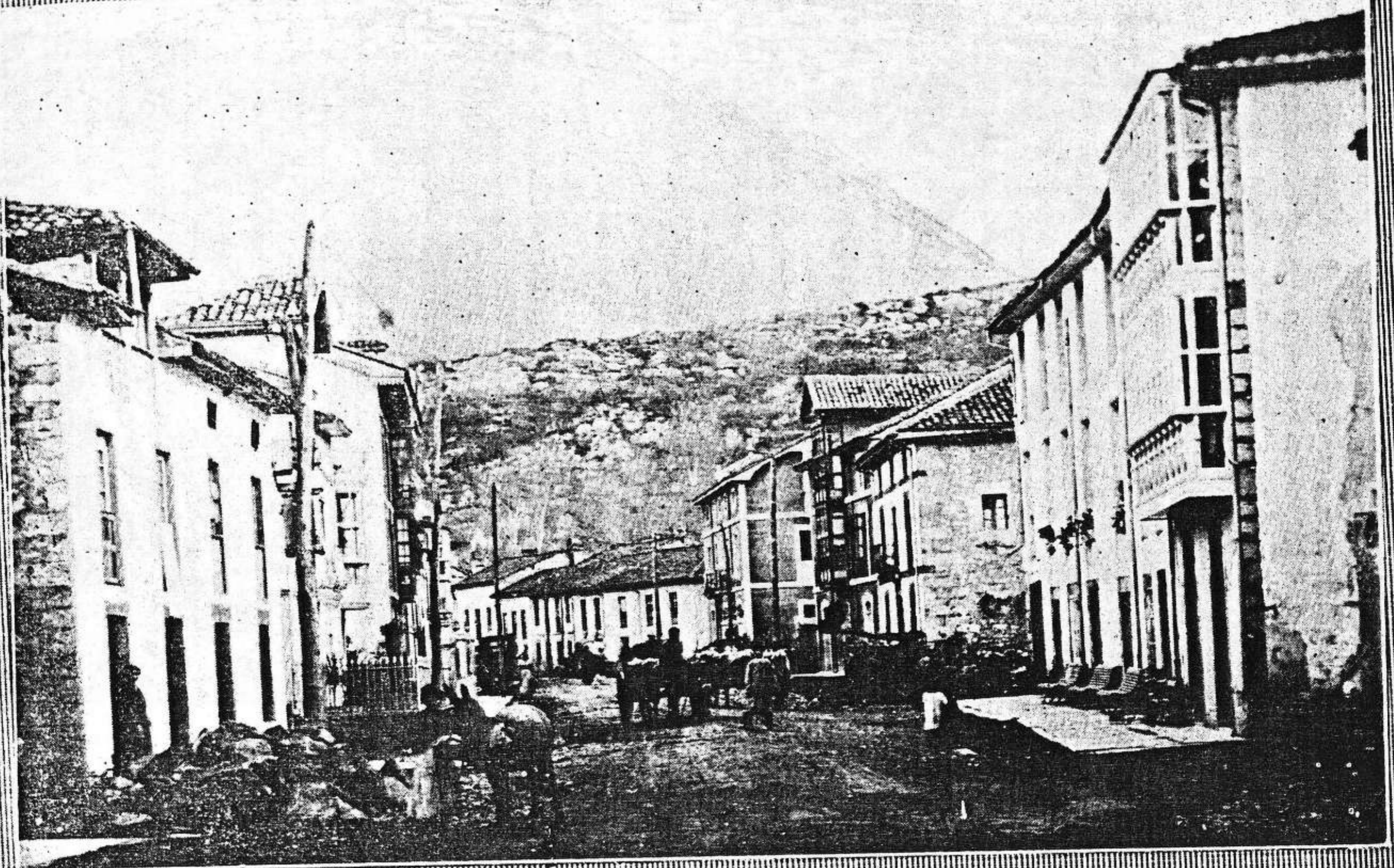
PANES.—Detalle de extramuros y la carretera que da acceso al corazón de la "ciudad"
